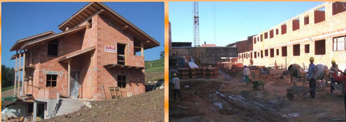
Figura 2 – Exemplos de estruturas resistentes em alvenaria.
