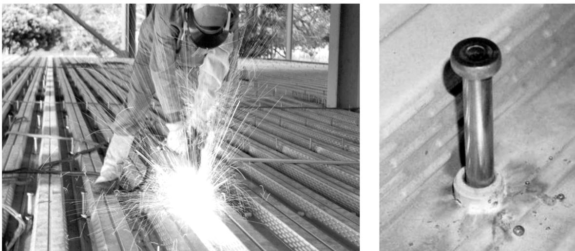
Figura 2 - O conector *stud* – aplicação sobre *deck* metálico
