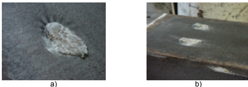
Figura 4: Roturas por corte na base dos pernos (CN13.1)
