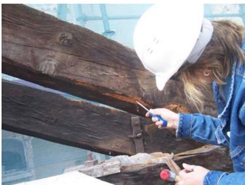
Figura 8 – Uso de ferramentas de inspeção na Tesoura 2
