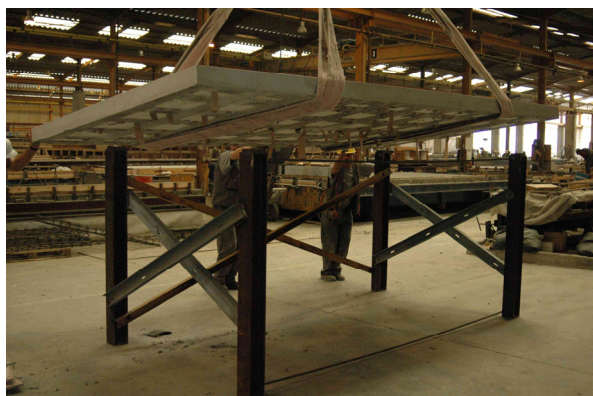
Figura 24 - Colocação do painel
