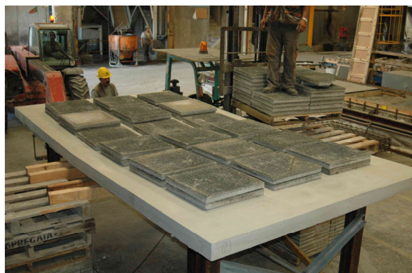
Figura 25 - Operação de colocação das lajetas
