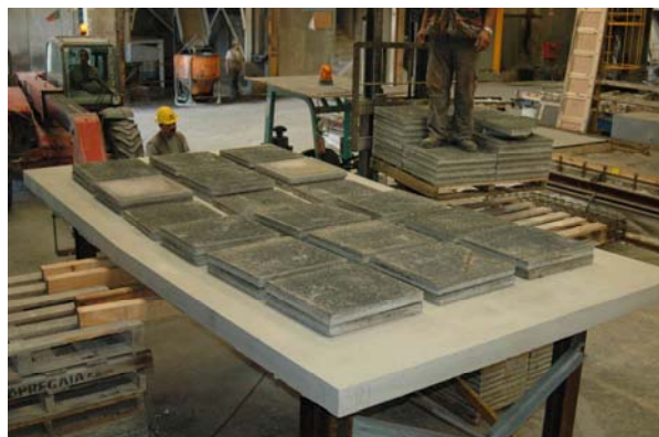
Figura 25 - Operação de colocação das lajetas
