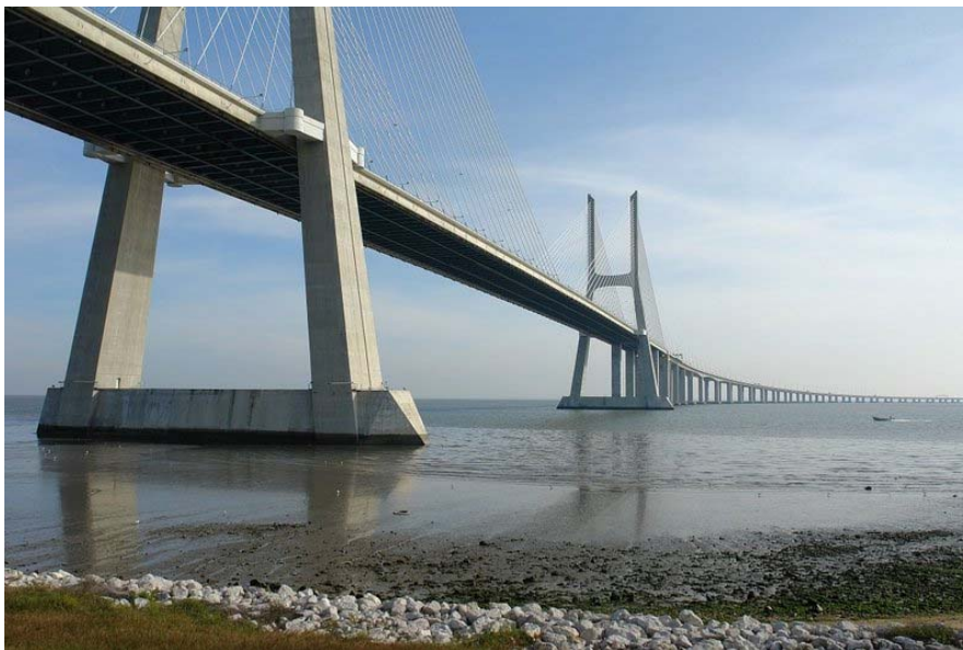
Figura 6 – Ponte Vasco da Gama, Lisboa.
