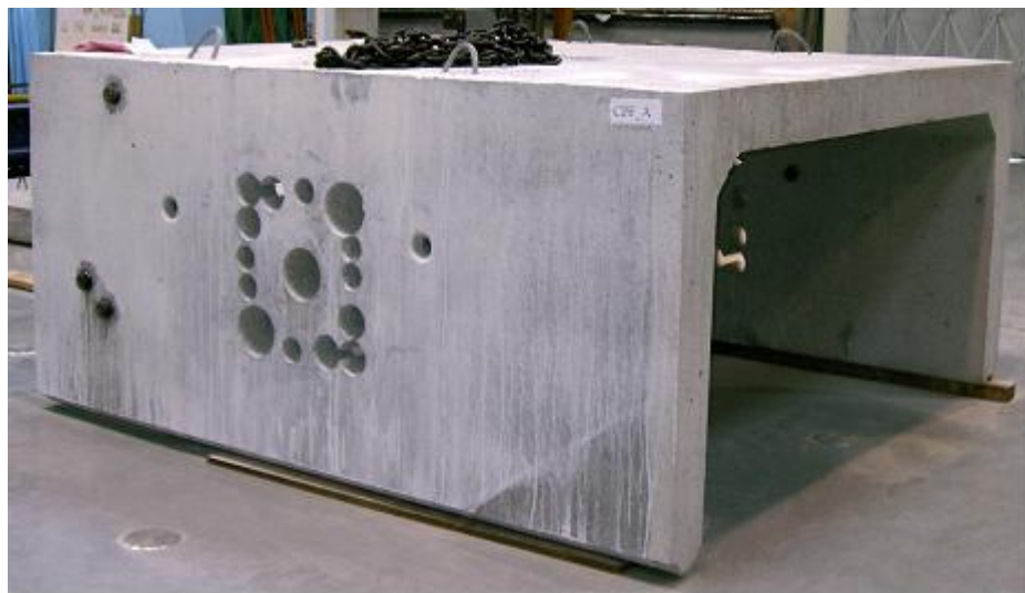
Figura 5 – Zona de extracção das carotes numa das paredes laterais do box-culvert .
