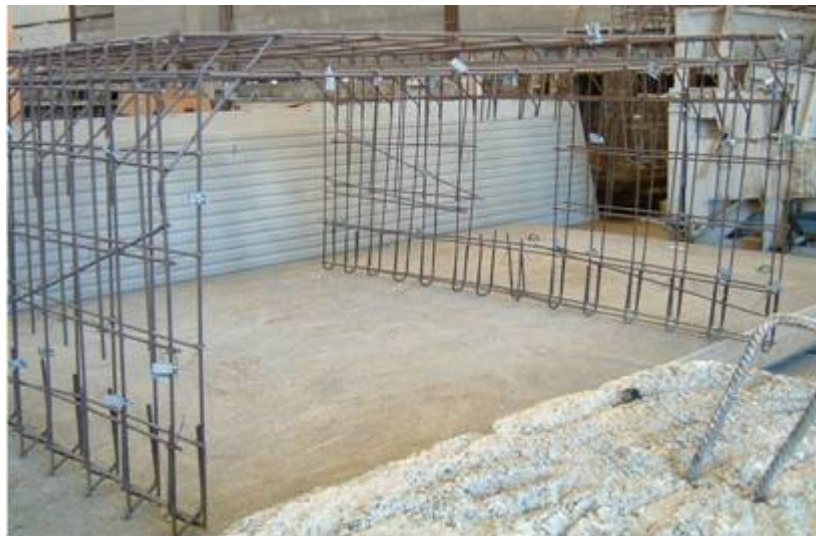
Figura 3 – Disposição da armadura nos elementos box-culvert betonados.
