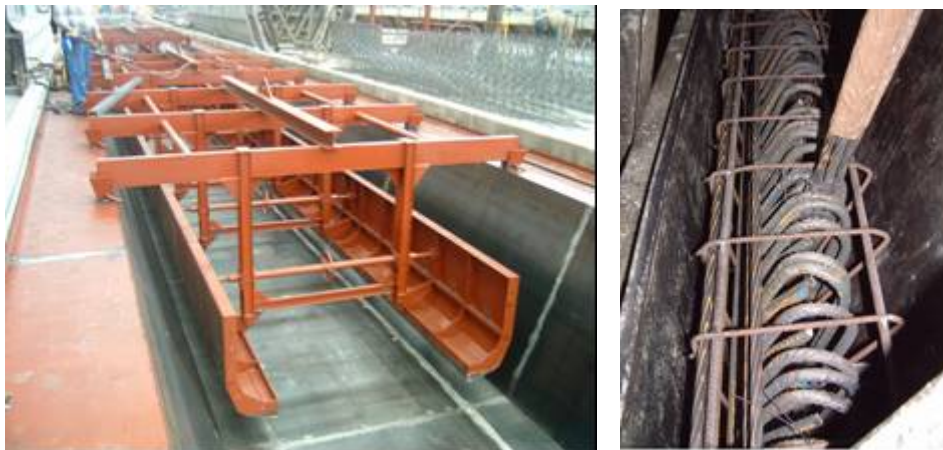
Figura 1– Sistema de cofragem (à esquerda) e densidade de armadura num elemento de viga (à direita).
