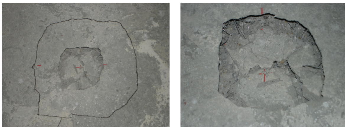
Figura 21 - Modo típico de rotura nos ensaios de punçoamento
