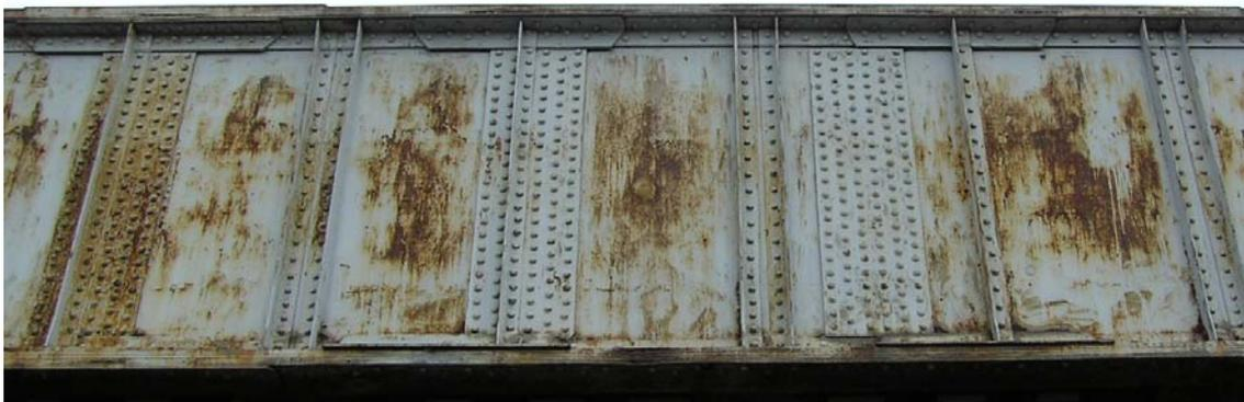
**Figura 4.4 – Corrosão em painéis de alma.**
