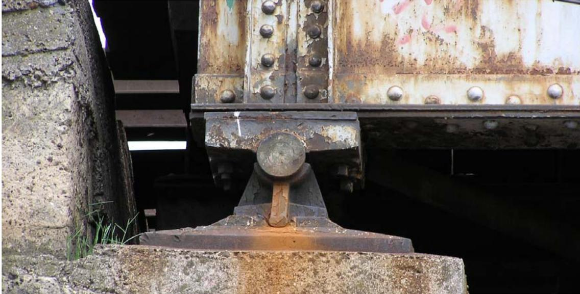
**Figura 4.5 – Corrosão nos apoios.**
