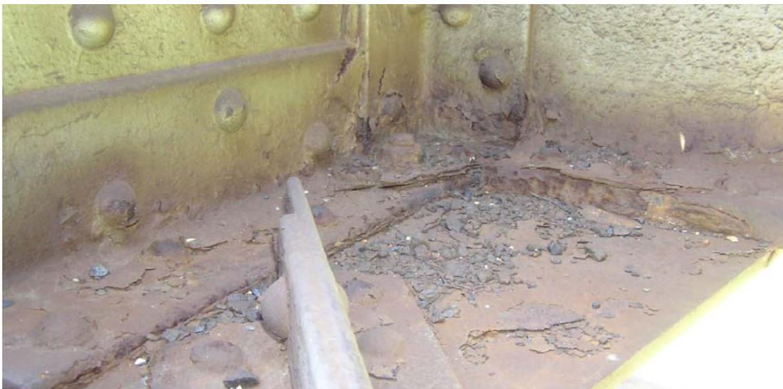
**Figura 4.6 – Corrosão por drenagem insuficiente.**
