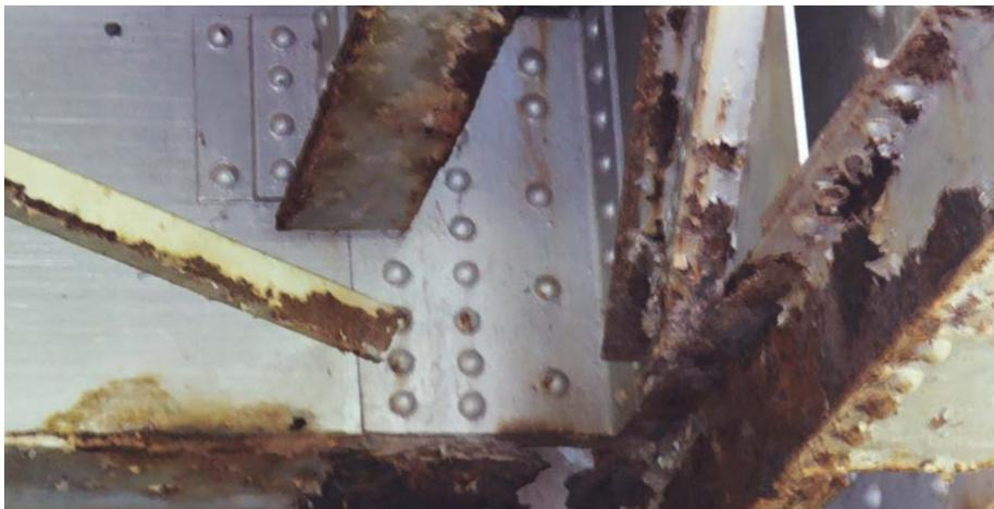
Figura 4.12 – Rotura frágil de um elemento estrutural.
