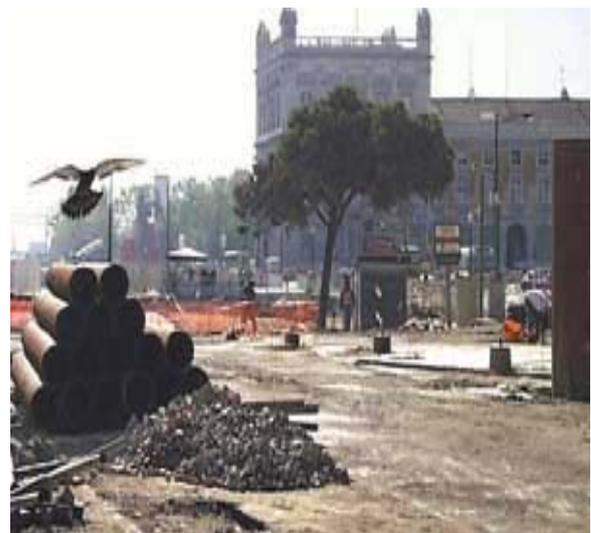
**Fig. 2. Estaleiro com vedação em rede plástica não constituindo qualquer protecção ao estaleiro**
