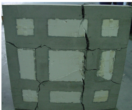
Figura 29. Padrão de fendilhação do painel no final do ensaio de flexão
