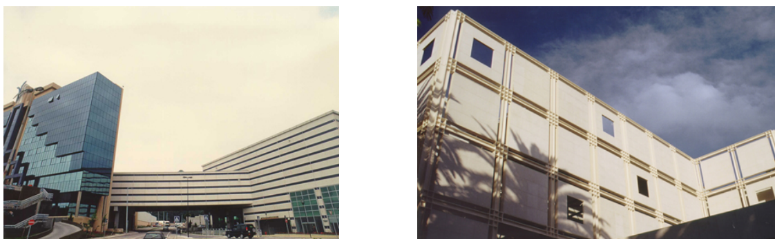
Figura 23 – Exemplos de aplicação de painéis de betão reforçado com fibras de vidro.
