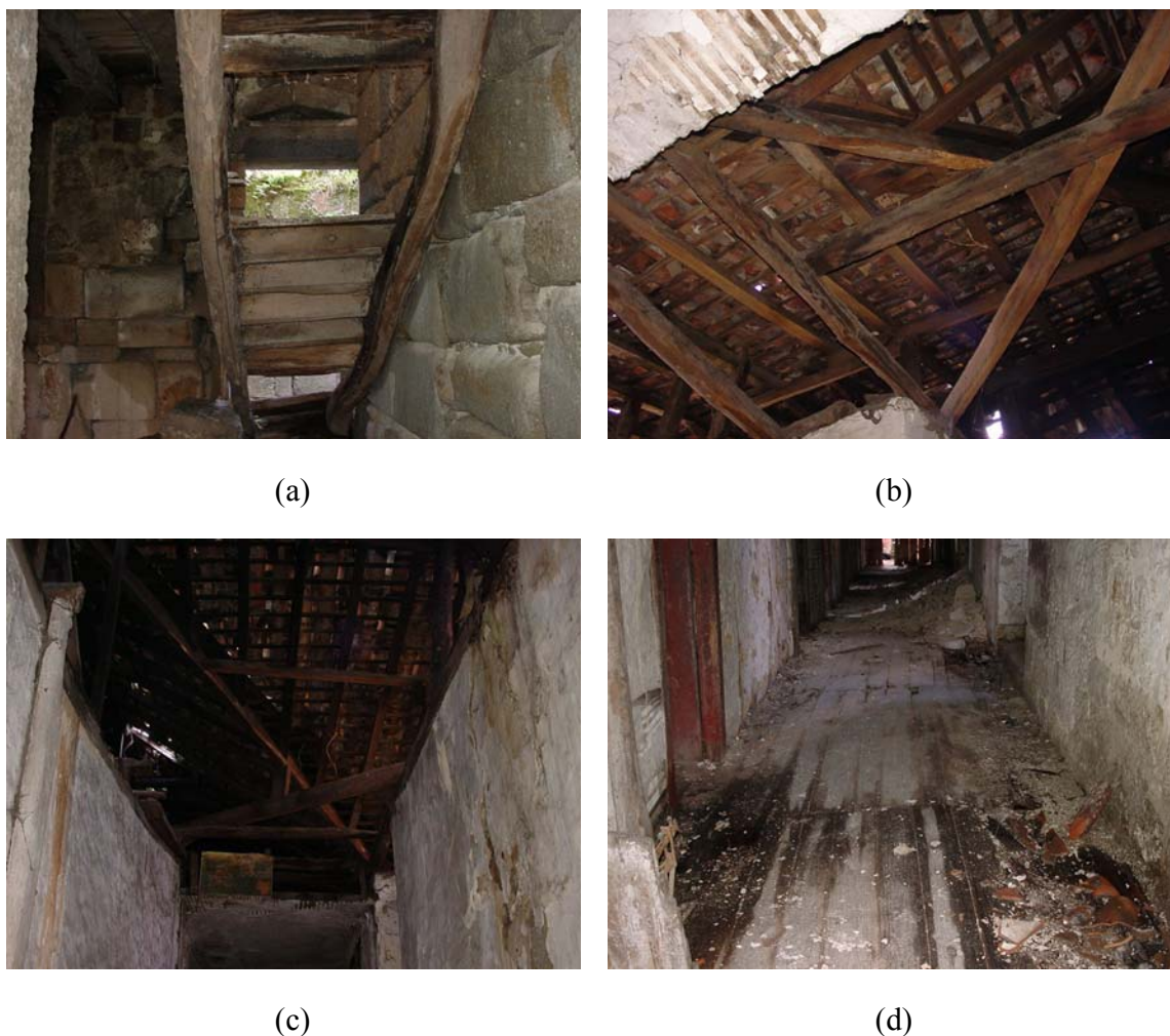
Figura 12 – (a) e (b) pormenores do edifício, (c) cobertura do 1º piso, e (d) aspecto geral do soalho.
