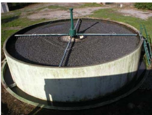
Figura 7 – Tanque percolador da ETAR de Ponte de Lima (vista superior).
