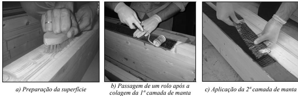
Figura 4 - Aplicação do sistema de reforço de CFRP curado “in situ” (manta)
