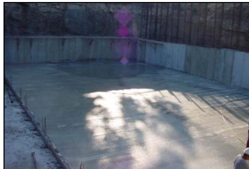
Figura 3 – Pavimento do polivalente em BRFA, sem juntas.
