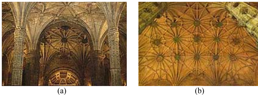
Figura 1. Abóbadas analisadas no presente estudo: (a) abóbada da nave e (b) abóbada do transepto
