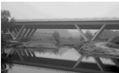
Figura 1: Vista geral da ponte sobre o Rio Ave
