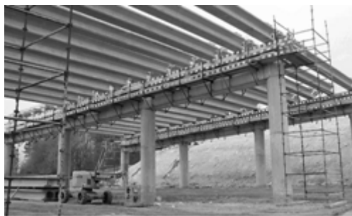
Figura 2: Viaduto de aproximação Este
