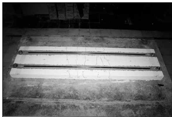
Modelo após a aplicação do Sistema CarboDur S512
