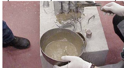
Figura 21 - Aplicação da argamassa epóxida nos furos de fixação dos laminados à sapata.
