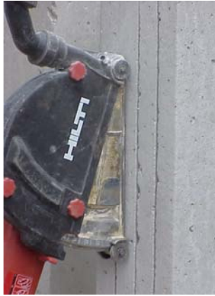
Figura 17 - Abertura das ranhuras.
