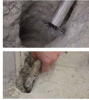
Figura 19 - Limpeza dos furos de fixação dos laminados à sapata.
