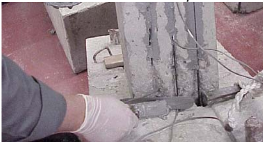
Figura 20 - Fixação dos laminados a um elemento de pilar.
