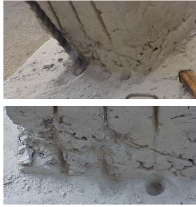
Figura 18 - Abertura dos furos de fixação dos laminados à sapata.
