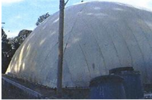
Figura 4.5: Vedação vertical pneumática [10]
