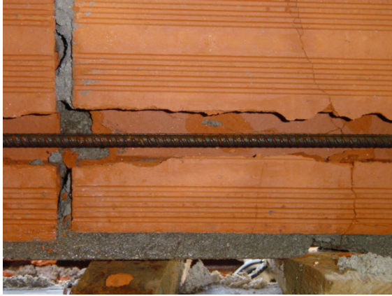
Figura 8.13: Remoção completa do septo vertical exterior de um dos furos dos tijolos para aplicação da armadura
