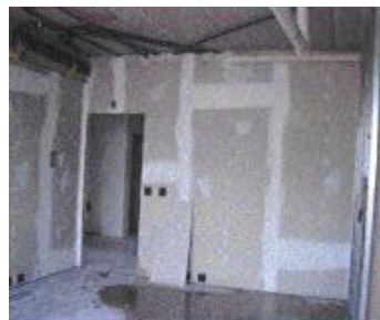
Figura 4.3: Vedação vertical interna de compartimentação [10]
