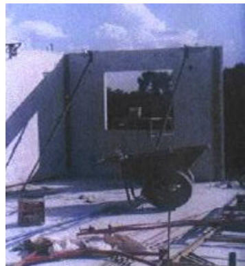
Figura 4.4: Vedação vertical executada por acoplamento húmido [10]
