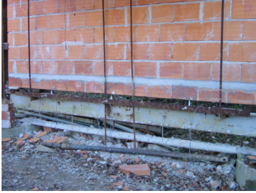
Figura 8.21: Aspecto da parede na zona onde foi efectuada a reabilitação
