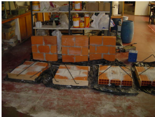
Figura 7.19: Construção dos provetes
