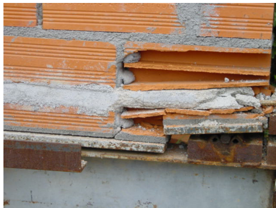
Figura 8.16: Rotura por esmagamento dos septos verticais limítrofes do primeiro nível de furos do tijolo
