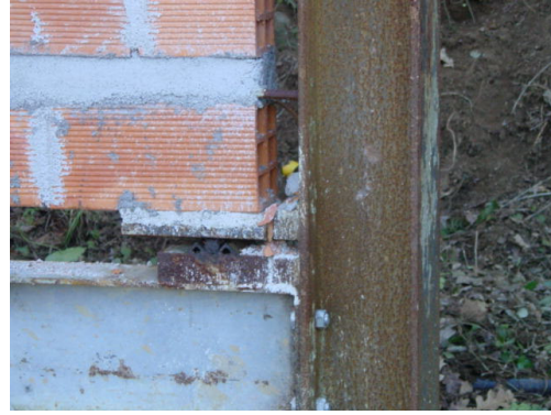
Figura 8.22: Detalhe da reabilitação junto ao apoio da parede
