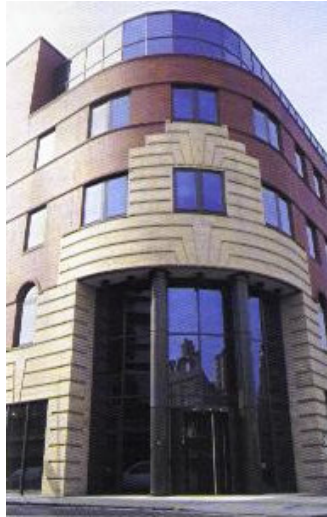
Figura 2.4: Edifício de serviços em King Street – Londres, executado em alvenaria armada [4]
