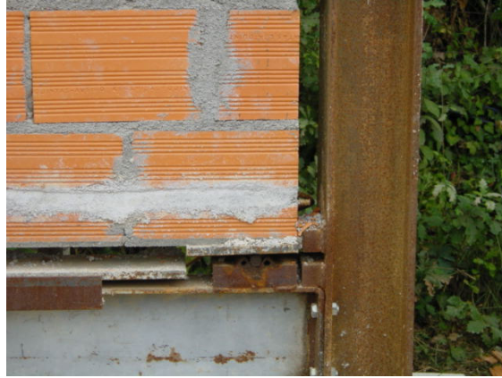
Figura 8.14: Aspecto exterior dos tijolos após o refechamento do espaço intervencionado com argamassa
