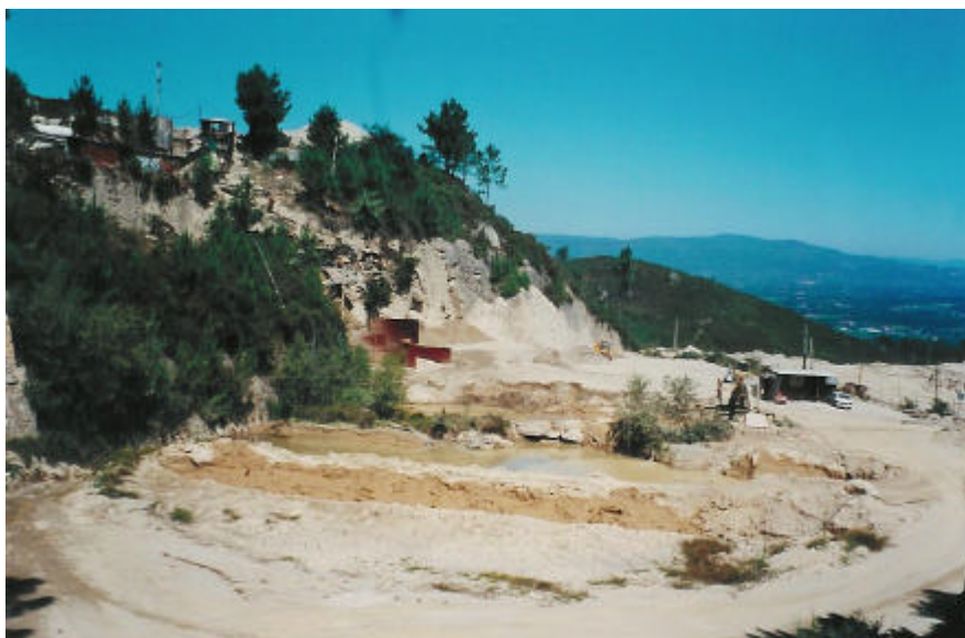
Fig. 2.13 - Vista parcial do estaleiro da Saibreira do Monte de Vasconcelos. Área de recepção das águas enlameadas.
