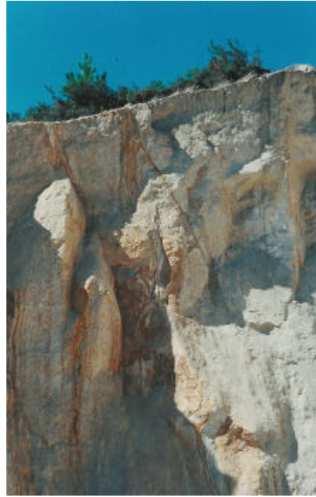
Fig. 2.19 - Frente de desmonte recente. Ocorrência preferencial de ferruginizações abaixo de plano de diaclase.
