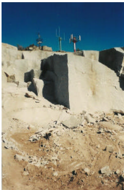
Fig. 2.2 - Frentes de desmonte da Pedreira Nª Sª do Amparo em Póvoa de Lanhoso.
