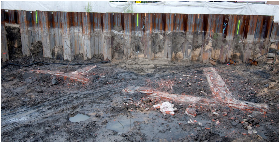
45 Het muurwerk (S 11) langs de Czaar Peterstraat
