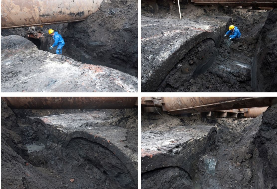
47 De gewelvbogen (S 15) in het tweede ontgravingsniveau van de bouwput. De gewelven zijn hoofdzakelijk gevuld met dezelfde klei (S 12) als waarin ze zijn aangelegd
