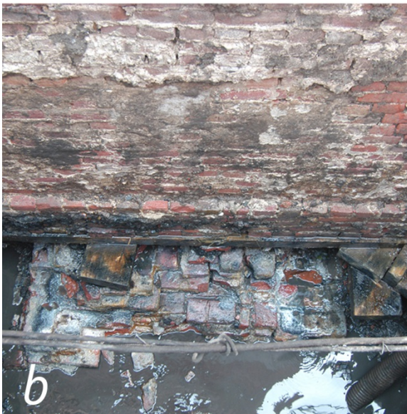
5a De schildmuur die in 1672 als extra versterking tegen de aardenwalmuur uit 1613 was geplaatst (MAR2), 5b bovenaanzicht van de schildmuur ter hoogte van het funderingshout van Marnixstraat 202 (MAR1), 5c muurresten van de rechterflank van bolwerk Slotermeer ter hoogte van Marnixkade 79 (MAK)
