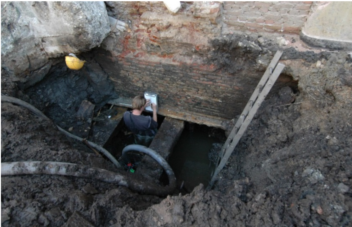
10 Bij de bouw van de achtergevel van het theater Bellevue in 1840 heeft men gebruik gemaakt van de fundering van het voormalige bolwerk Sloten
