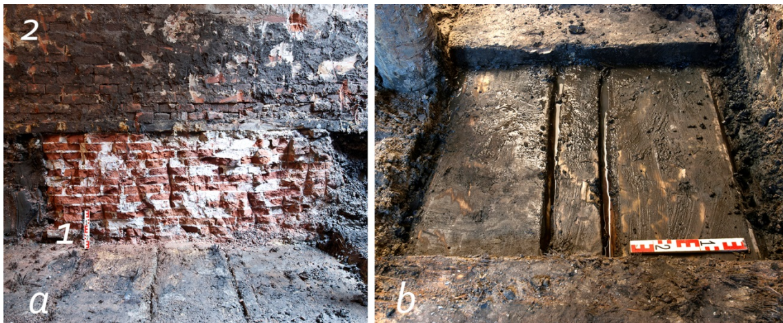
24 a De schildmuur (1) en funderingsvloer (2) uit 1663 gezien ter hoogte van de zijgevel tussen Marnixstraat 360 en 362 uit 1889, b het funderingshout onder de gewelfrib ter hoogte van Marnixstraat 360 (MAR8)
