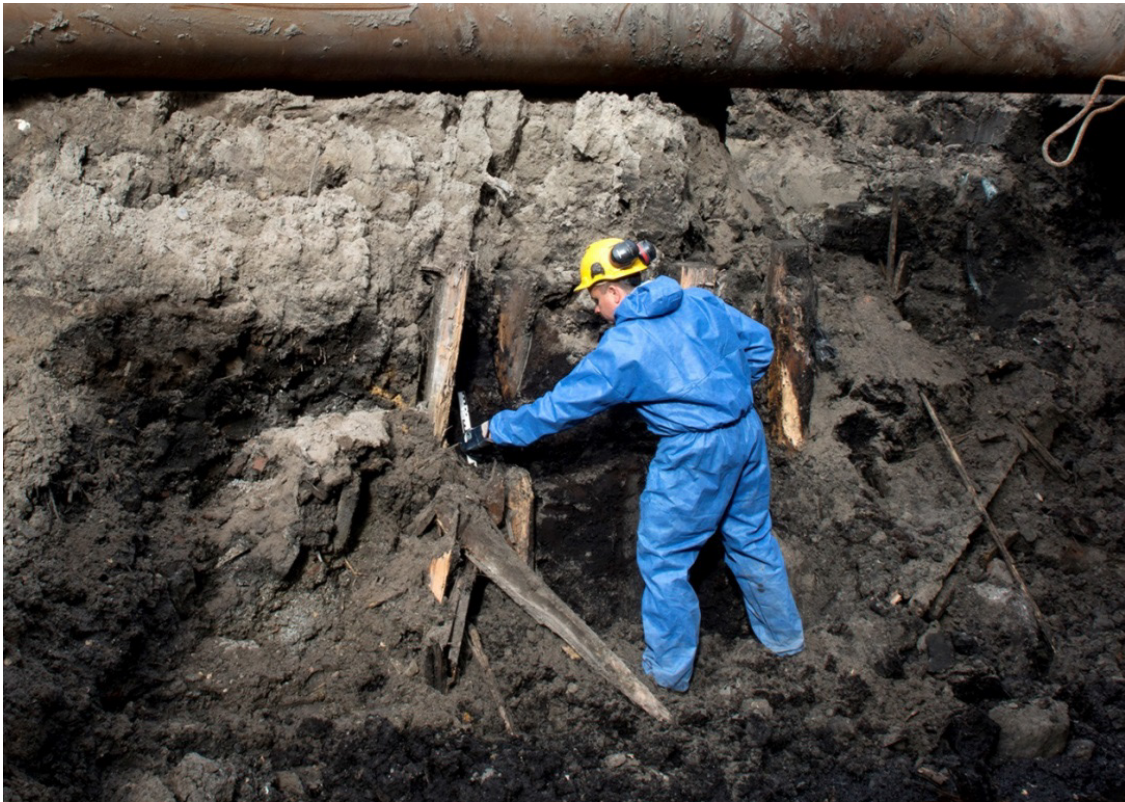
36 Enkele rechtopstaande planken met messing-en-groef markeren de grens tussen de heipalen van de stadswal (rechts) en de aangeplempte singelgracht (links)
