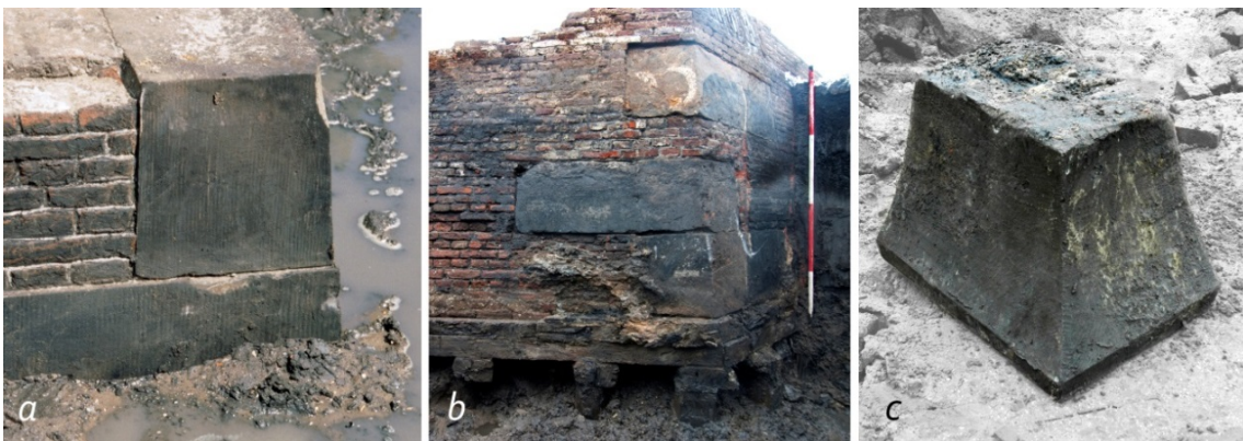
9 Bij de aanleg van de bolwerken werd in de saillant en in de hoeken tussen flank en face natuursteen verwerkt, a = de saillant van bolwerk Zeeburg, b = de hoek tussen zuidflank en face van bolwerk Oosderblokhuis, c = blok uit de saillant van bolwerk Oosderblokhuis
