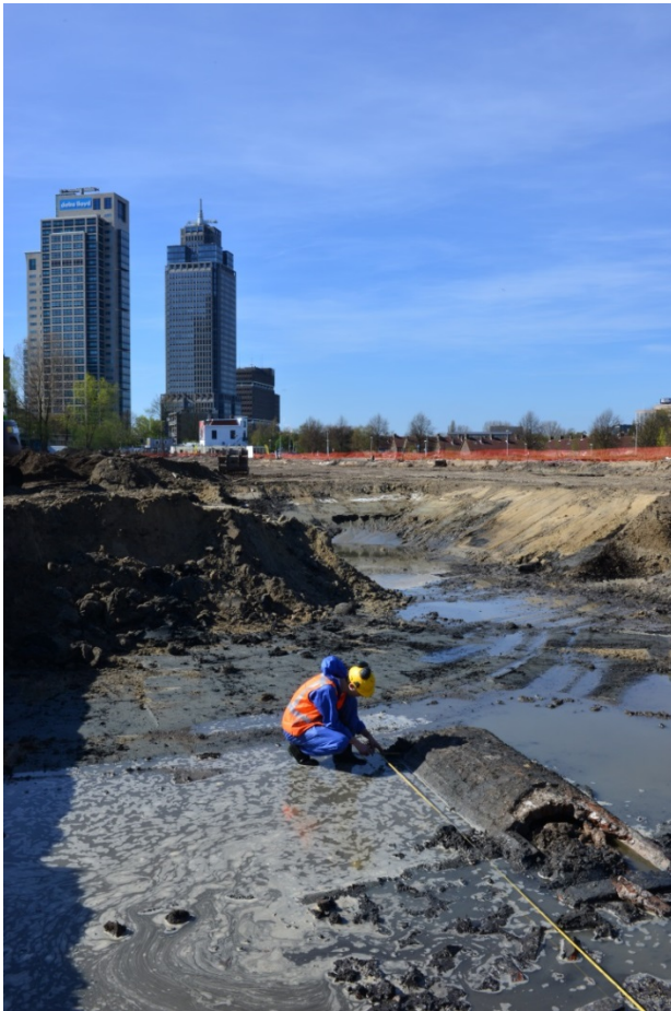
11 De 19de-eeuwse waterkelder (S 7), gezien in noordelijke richting
