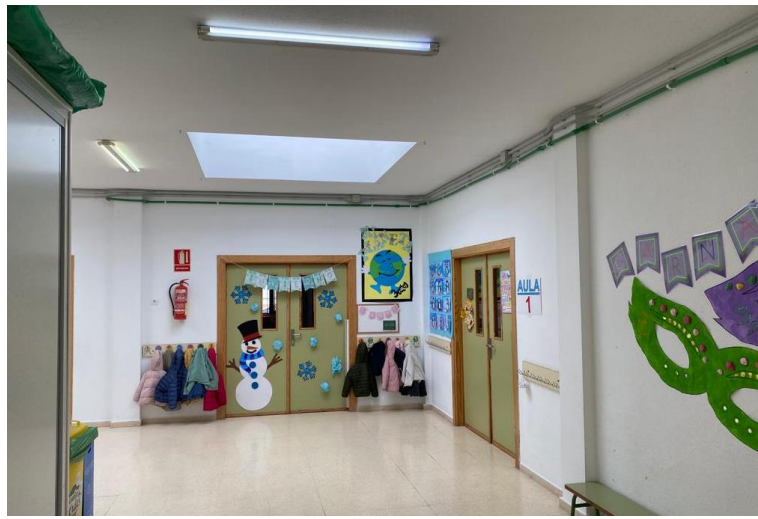
Fig. 30 Zona de entrada del pabellón de infantil donde se pueden apreciar las instalaciones vistas y el lucernario. Fuente: Elaboración propia.
