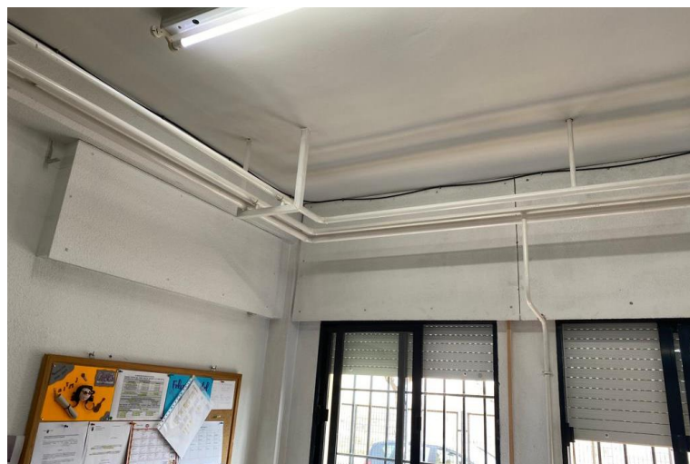
Fig. 42 Detalle de la sala de administración donde se pueden ver las diferentes instalaciones. Fuente: Elaboración propia.
