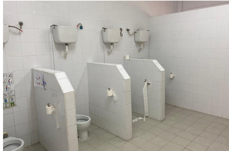
Fig. 31 Aseos del pabellón de infantil. Fuente: Elaboración propia.
