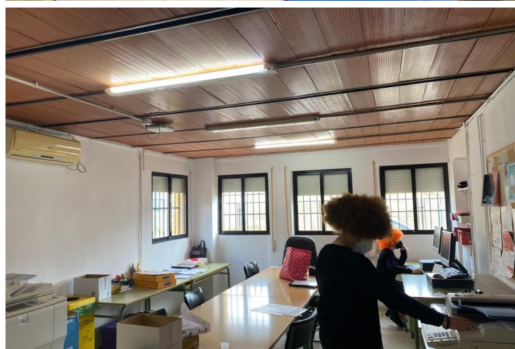
Fig. 41 Sala de profesores donde se pueden apreciar las instalaciones y las bovedillas cerámicas del forjado. Fuente: Elaboración propia.
