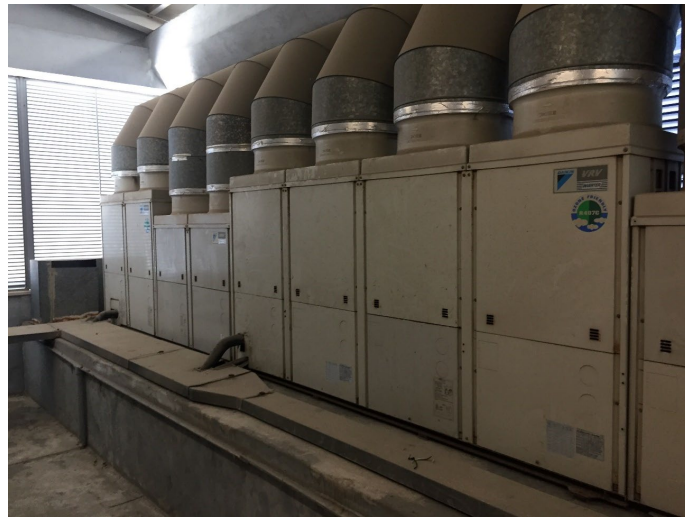
Figura 27: Sistema AQS e AVAC das Casernas
