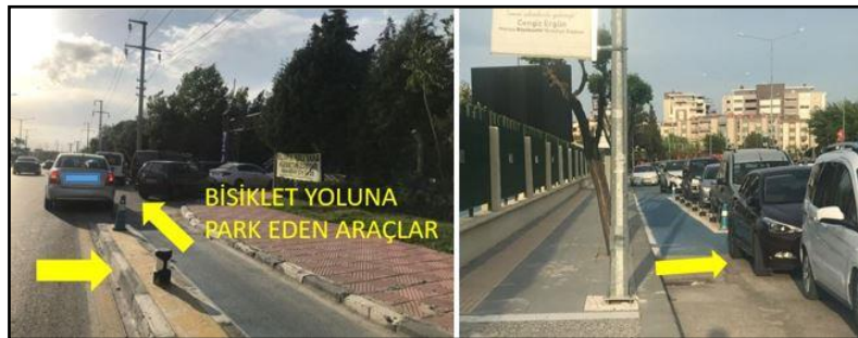
Şekil 5. Manisa mevcut bisiklet yolu güzergâhlarında tespit edilen sorunlu alanlar
