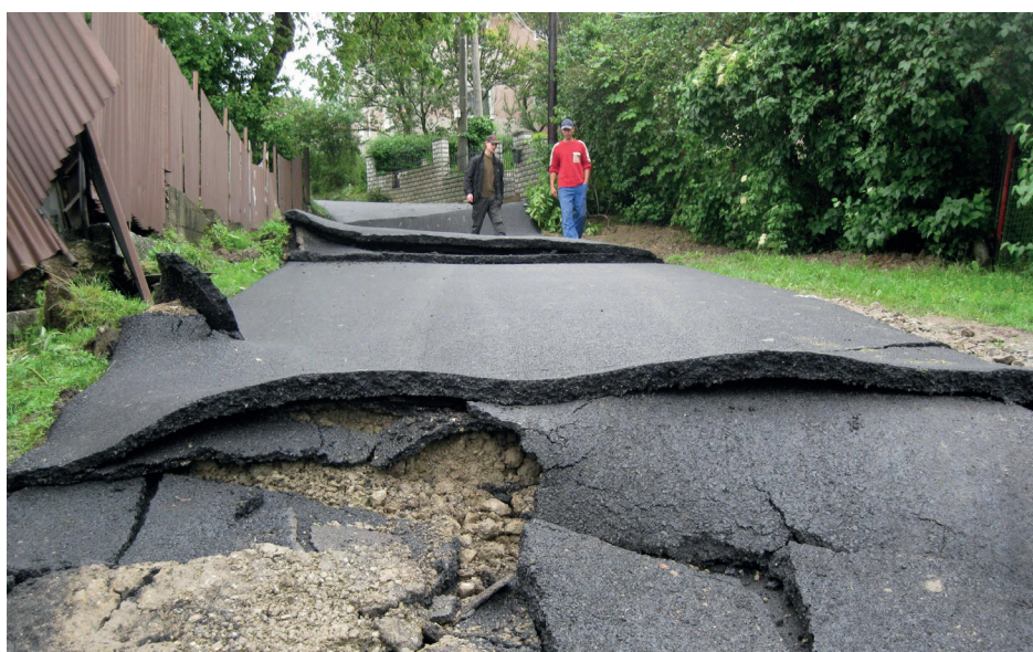
Obr. 2. Zosuvom deštruovaná, v tom čase novovybudovaná komunikácia na ulici Repiská (archív oddelenia IG ŠGÚDŠ, 4. 6. 2010).
