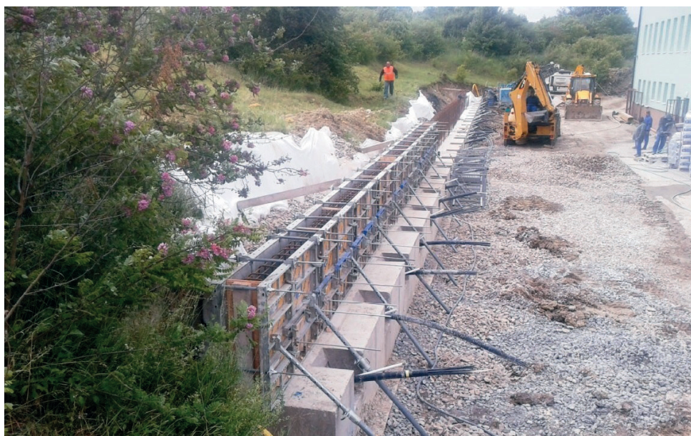
Obr. 11. Druhá etapa sanácie: kotvená pilótová stena nad budovou základnej školy – osadené trvalé horninové kotvy v železobetónovom nosníku a zhotovovanie zárubnej stienky a drénu za stienkou (Gomolčák, 2014).
