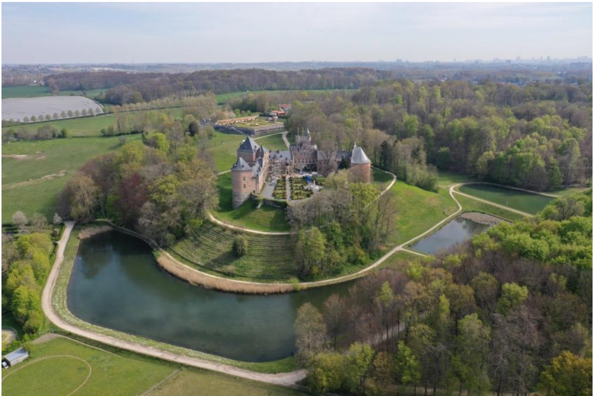
Figuur 5: Luchtfoto van het kasteel van Gaasbeek, de binnentuin het park errond vanuit het zuiden (© agentschap Onroerend Erfgoed: Johan Van Laecke).
