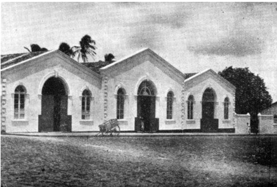
Figura 5. Estação Ferroviária de Feira de Santana nos anos 1930.
