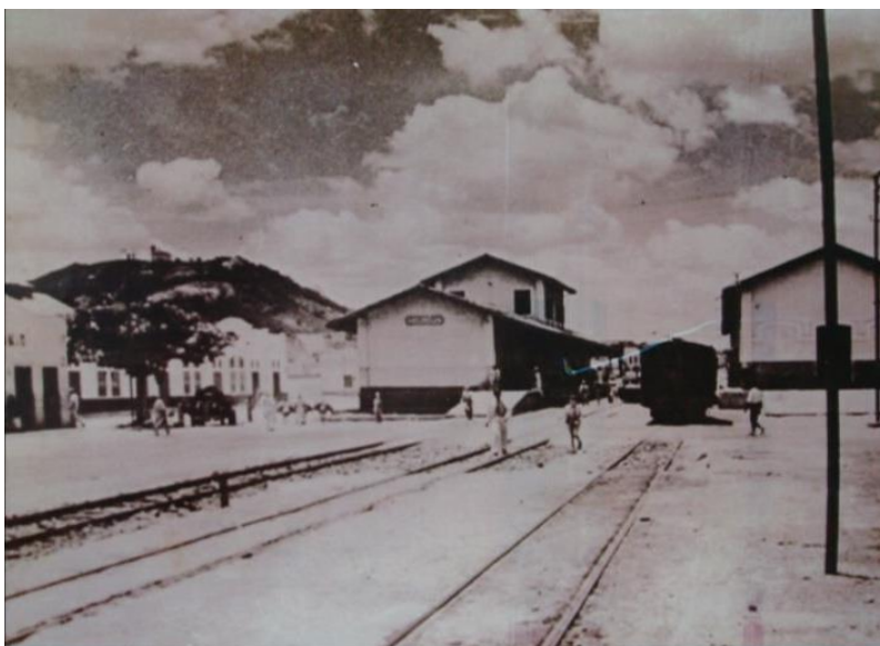
Figura 9. Caruaru. No primeiro plano os trilhos da ferrovia, ao fundo, a Estação Ferroviária e à esquerda o edifício da indústria Boxwell. Foto sem data
