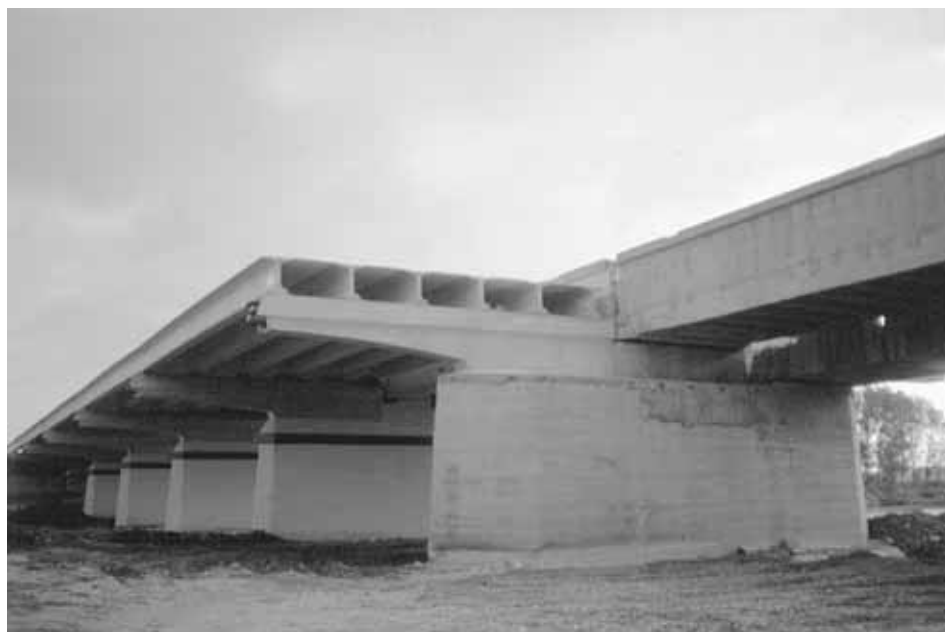
Fig. 2. Puente de La Almozara.
