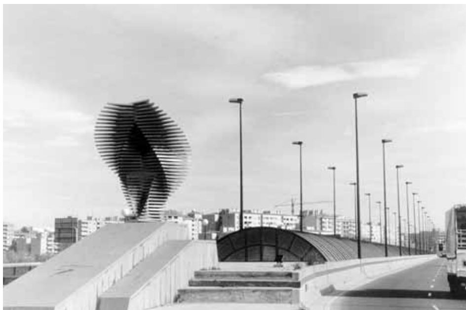
Fig. 3. Puente de La Almozara.
