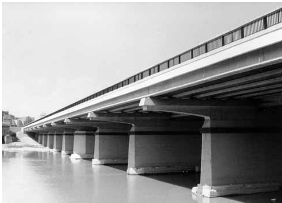
Fig. 1. Puente de La Almozara.
