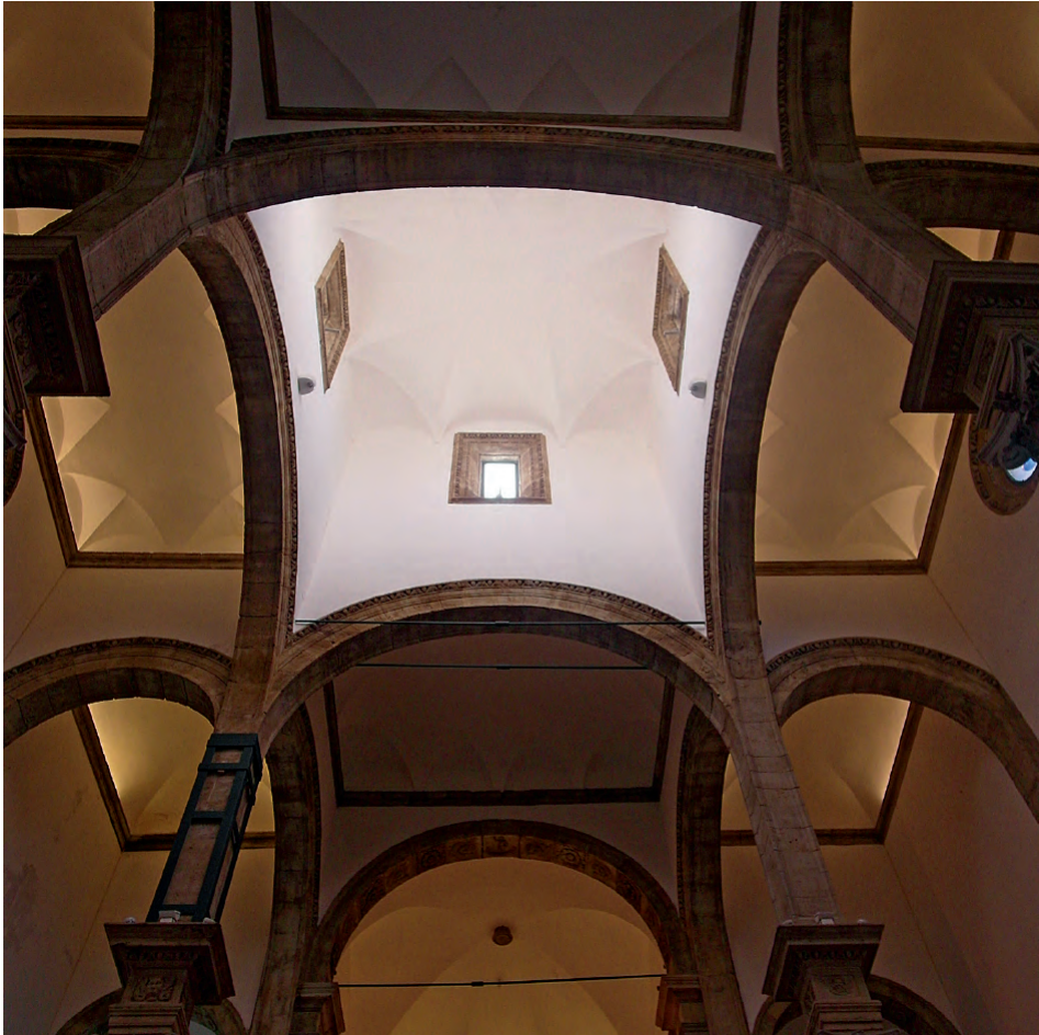
Fig. 23. Palermo. Church of S. Maria dei Miracoli, view of the vaulting system.
