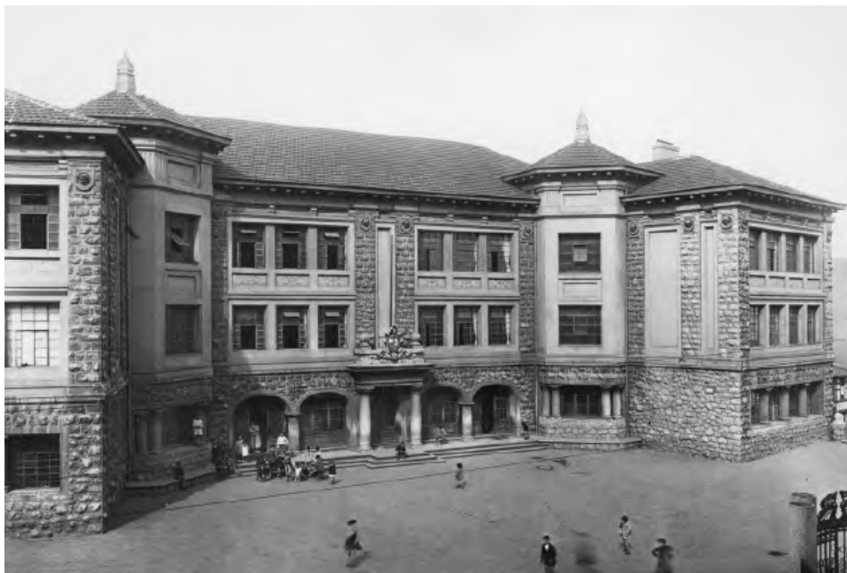
Fig. 6. Escuela de Torre Urizar. BUA/ AMB. Fondo Ayuntamiento de Bilbao. 01_002302_F-000137-003.
