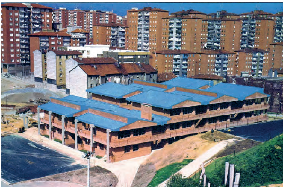
Fig. 16. Escuela de Mina del Morro del plan de urgencia de construcciones escolares. 1973. Plan de Construcciones Escolares 1966-1973, Bilbao, Imprenta Industrial, 1973, s.p.
