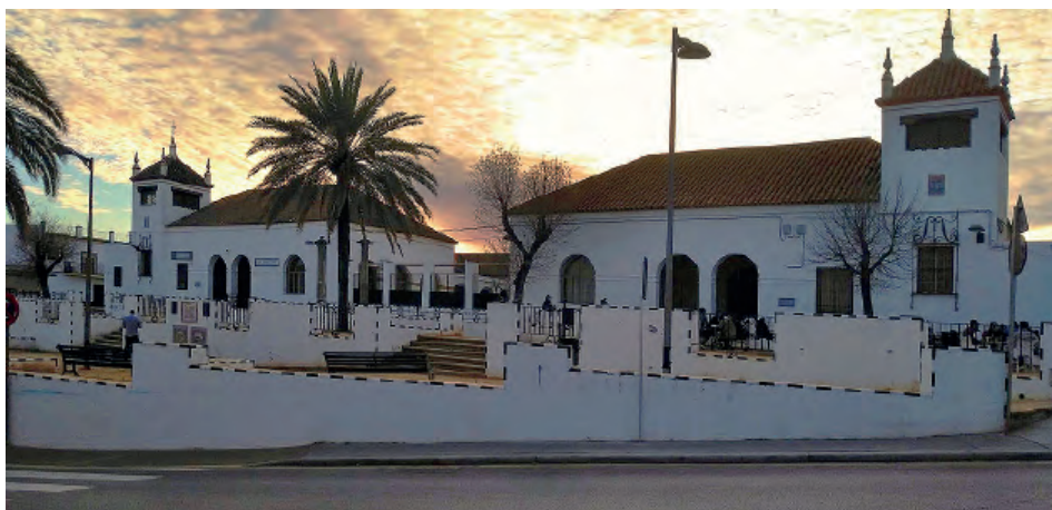
Fig. 9. CEIP Pedro Gutiérrez en Alcalá de Guadaíra, 1926-28, arquitecto Juan Talavera. Fotografía de la fachada a la Plaza de España. Marzo de 2020.
