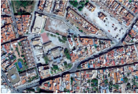
Fig. 6. Doble grupo escolar graduado en Morón de la Frontera. Actualmente CEIP Los Grupos. Corresponde con proyecto de 1930 de los arquitectos Pedro Fernández de Heredia y Antonio Illanes del Río.
