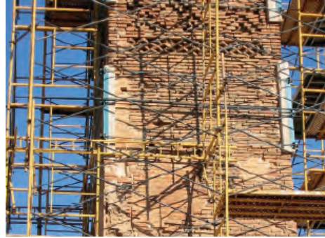
Fig. 11. Levantamiento del andamio perimetral.
