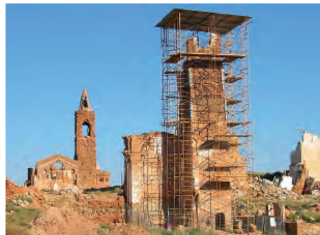
Fig. 15. Colocación de una cubierta temporal.
