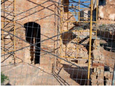
Fig. 10. Delimitación de seguridad y recalce de la cimentación.
