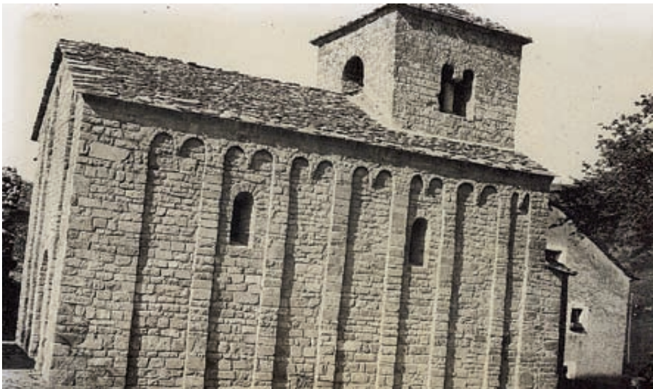
Fig. 8. San Caprasio tras la restauración de Chueca Goitia. Aprox. 1959. Archivo familiar empresa Tricás.
