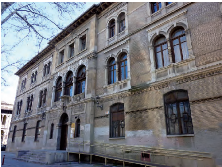
Fig. 5. Fachada principal de la Escuela de Artes de Félix Navarro. Estado actual.
