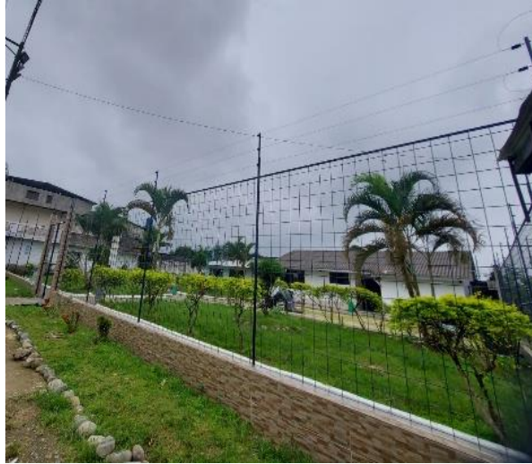
Figura 19: Instalación de los postes.
