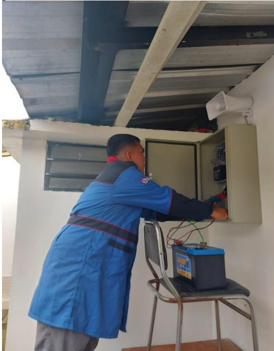
Foto 1: Instalando los componentes del cercado y panel eléctricos.
