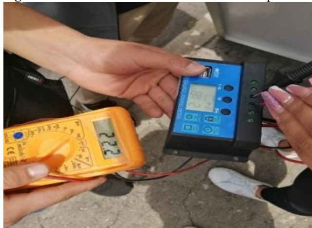
Figura 13: Medición eléctrica con multímetro del panel solar.
