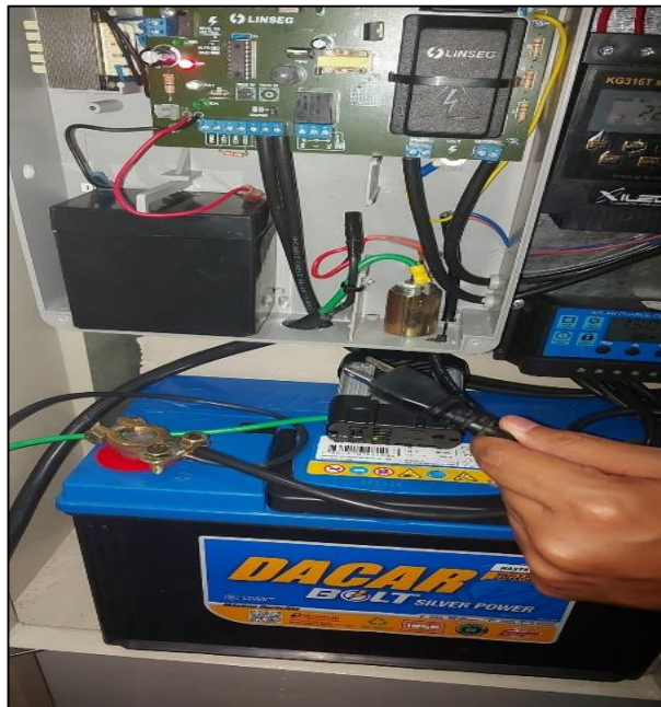
Figura 23: Montaje de la batería
