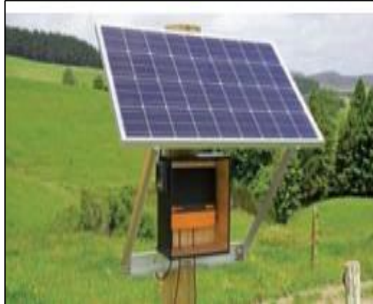
Figura 8: Energizadores de alimentación múltiple.
