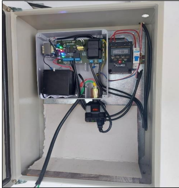
Figura 22: Montaje de los componentes eléctricos
