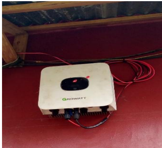
Figura 22. Instalación del inversor en el interior del bloque “B”
