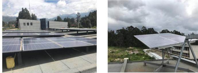
Figura 16. (a) Modulo fotovoltaico con estructura fija, (b) Modulo fotovoltaico con seguidor de dos ejes.
