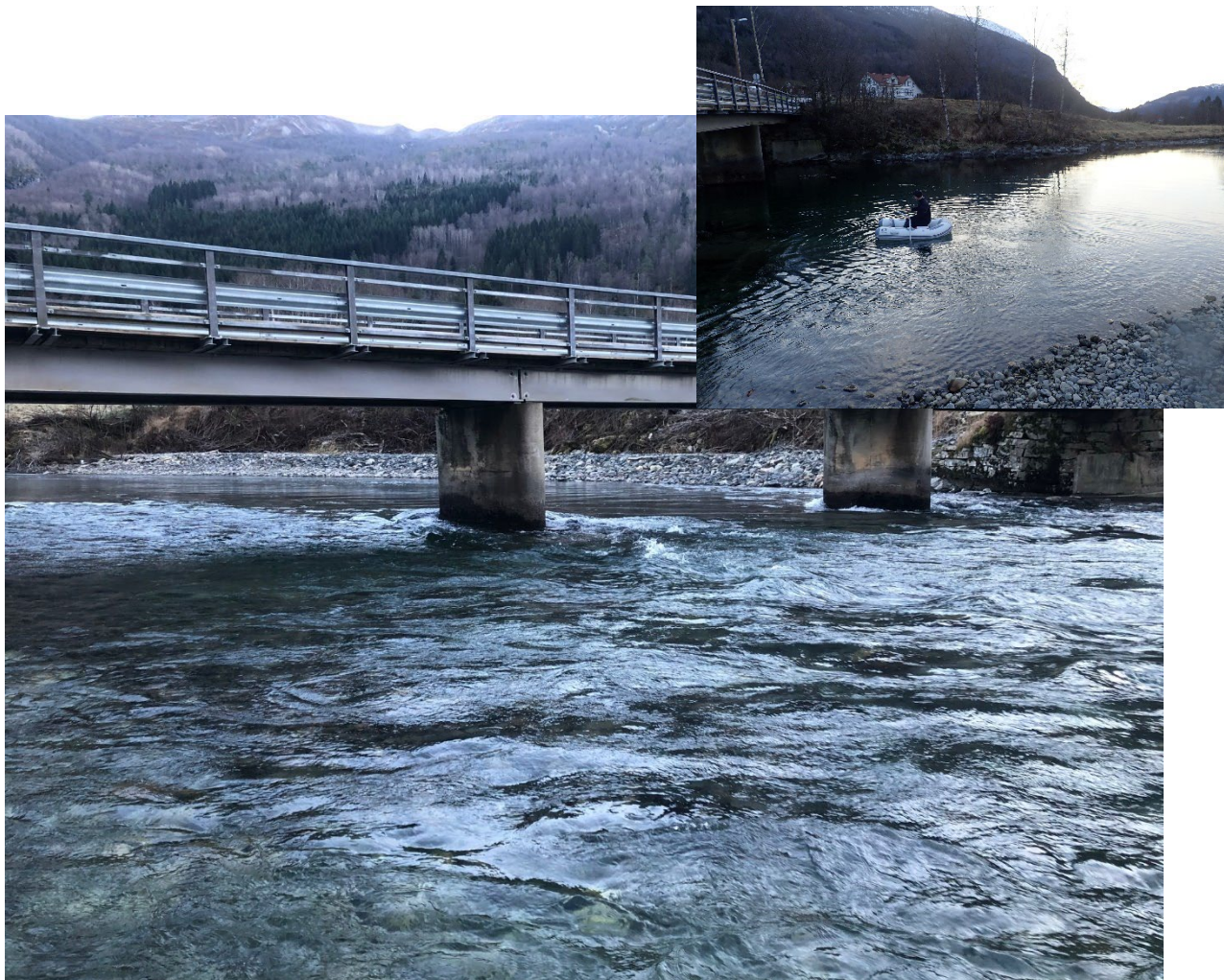
Figur 39: strømforholdene under broen 20.11.2022. Det danner seg et stryke, til sammenligning kulpkarakter før sikringstiltakene (opp til høyre). Bilde tatt av Knut Stauri
