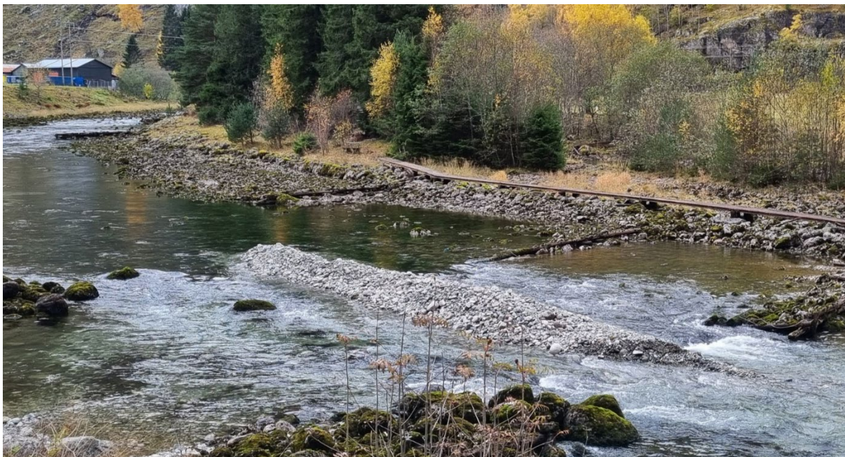
Figur 29. Grusutlegg i Aurlandselva. Flommen selv skal fordele massene.
