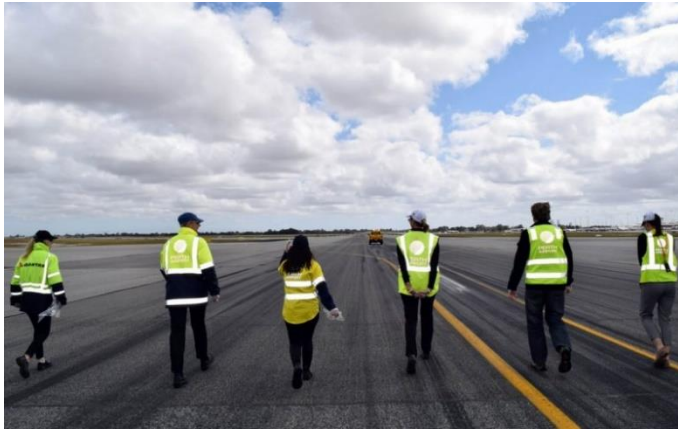
Figura 11: Inspección de pista
