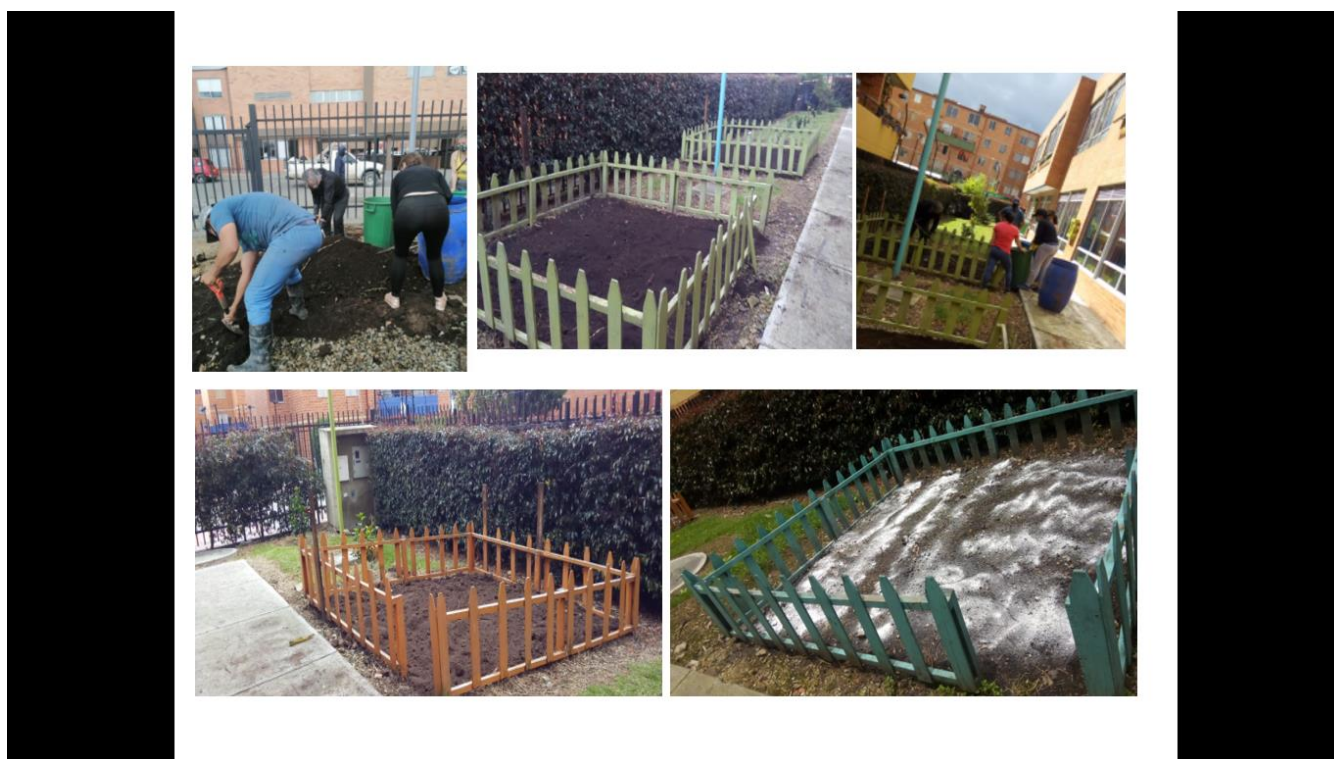
Ilustración 6. Registro Fotográfico - Alistamiento del Terreno, Agosto 2021
