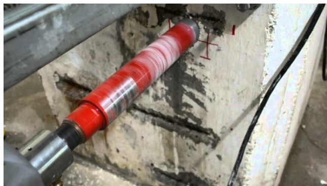
Figura N° 2. Ensayo de diamantina. (Extracción de núcleos de concreto., 2014)
