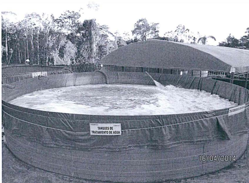
**Fotografía N° 8.** Tanque de tratamiento de aguas residuales industriales.
