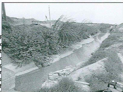
Fotografías N° 02 y 03. Lado izquierdo: Canaleta de flujo del agua residual industrial de color gris y con alta turbidez procedente del hidropulper de la planta Trupal, donde se ubicó el punto de muestreo EP. En el lado derecho, las muestras extraídas notándose el cambio de color de gris a amarillo.
