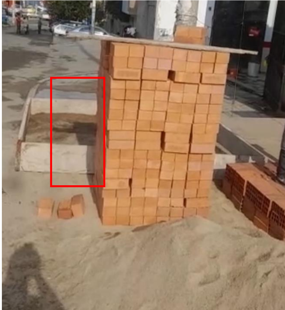
Figura N 101: Armado de cubera en Obra con gestión en Villa el Salvador
