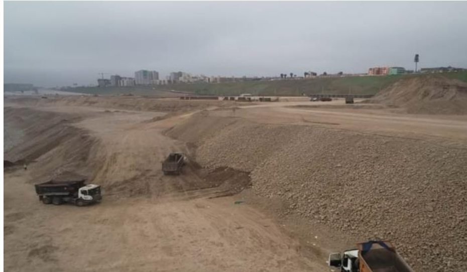
Figura N 59: Segundo punto de inspección visual.
