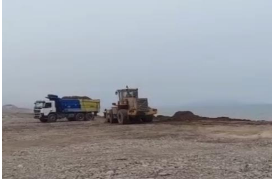
Figura N 61: Segundo punto de inspección visual. Fuente: Elaboración propia ADEICS.
