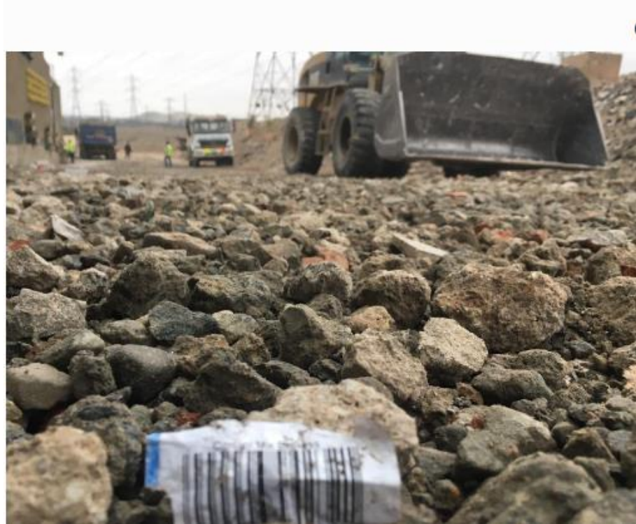
Figura N 53: Trituración del concreto o desmorte Fuente: Cajas Ecológicas. Tomada de: https://www.cajas-ecologicas.com/servicios/
