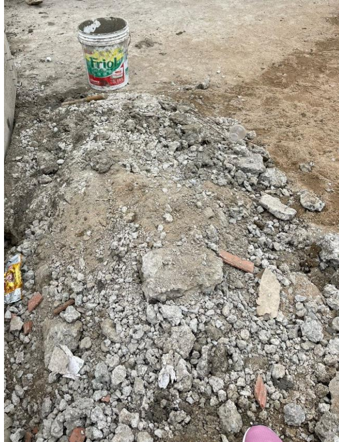
Figura N 97: RCD a eliminar Fuente: Supervisión de Obra Proyecto Vivienda Unifamiliar-SACRE INVERSIONES S.A.C- septiembre 2022
