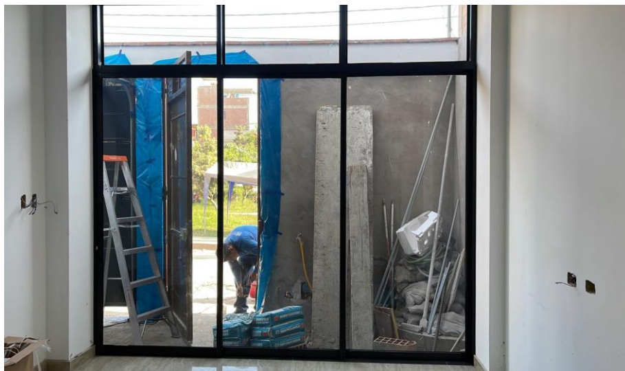
Figura N 47: Colocación de mampara del primer nivel.
