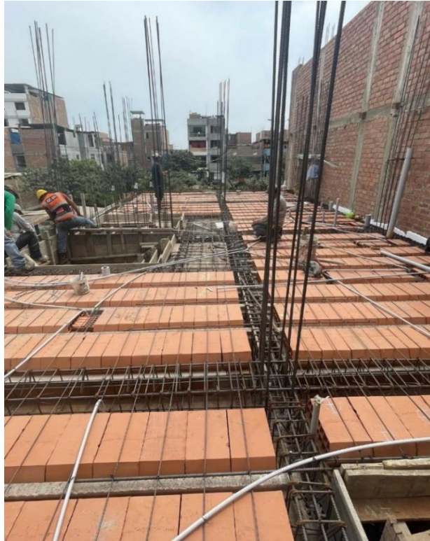
Figura N 42: Armado de losa del primer nivel Fuente: Obra Vivienda Unifamiliar Villa el Salvador-diciembre 2022
