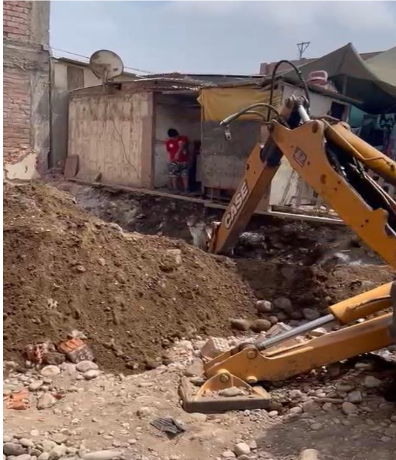
Figura N 38: Excavación de zapatas y zanjas
