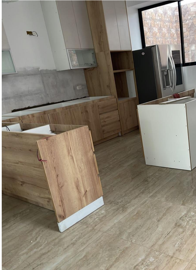
Figura N 48: Colocación de muebles de la cocina. Fuente: Obra Vivienda Unifamiliar Villa el Salvador-marzo 2022
