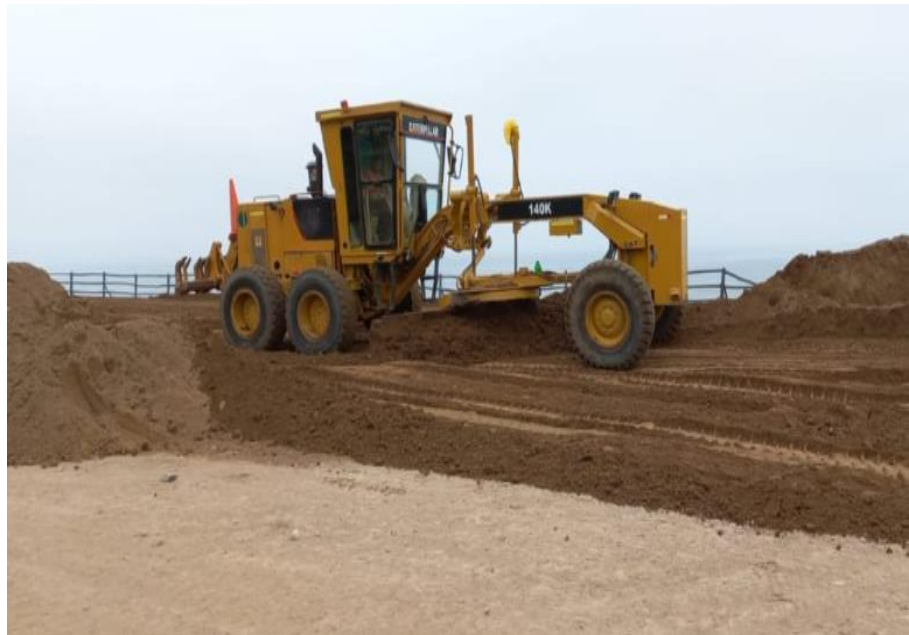
Figura N 68: Enrazado de suelo con motoniveladora. Fuente: ADEICS. Tomada de: file:///C:/Users/dsanchez/Downloads/ENTES%20EDUCATIVOS- %20PRESENTACION.pdf
