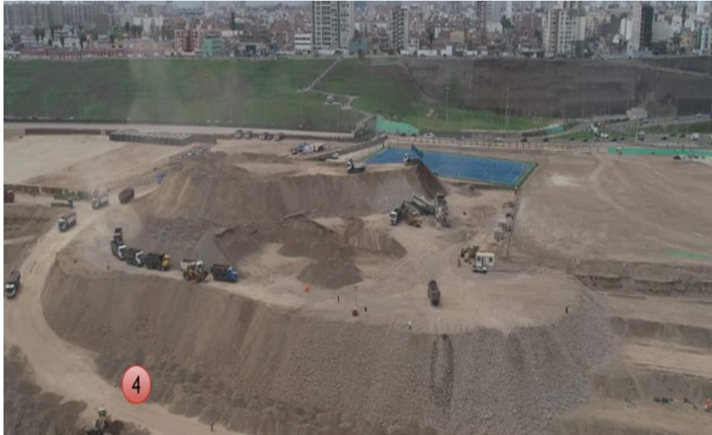
Figura N 63: Enrazado de suelo con cargador frontal. Fuente: ADEICS. Tomada de: file:///C:/Users/dsanchez/Downloads/ENTES%20EDUCATIVOS-%20PRESENTACION.pdf
