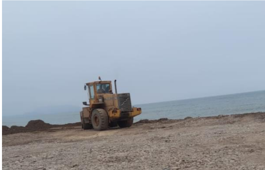
Figura N 65: Empuje de material para ganar espacio. Fuente: Elaboración propia ADEICS.
