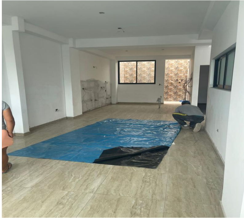
Figura N 46: Enchape del primer nivel.
