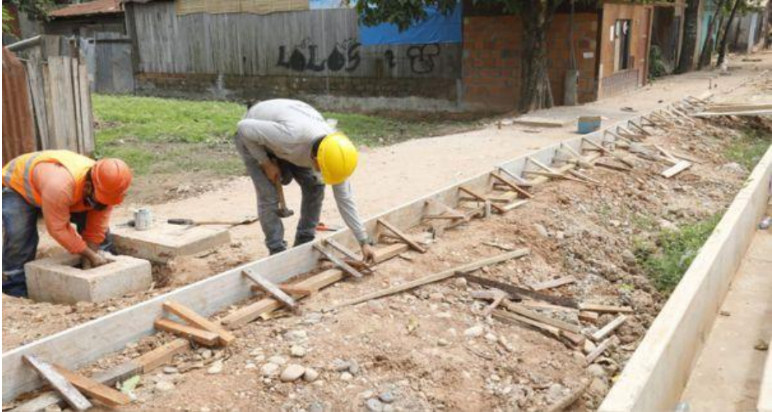
Figura N 9: Construcción de veredas con el árido reciclado Fuente: ANDINA/Difusión.
