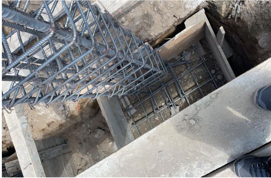
Figura N 40: Armado de zapata aislada Fuente: Obra Vivienda Unifamiliar Villa el Salvador- diciembre 2021
