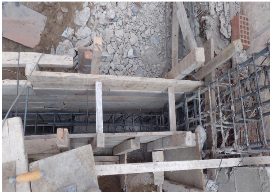
Figura N 41: Armado de Viga de cimentación. Fuente: Obra Vivienda Unifamiliar Villa el Salvador-diciembre 2021
