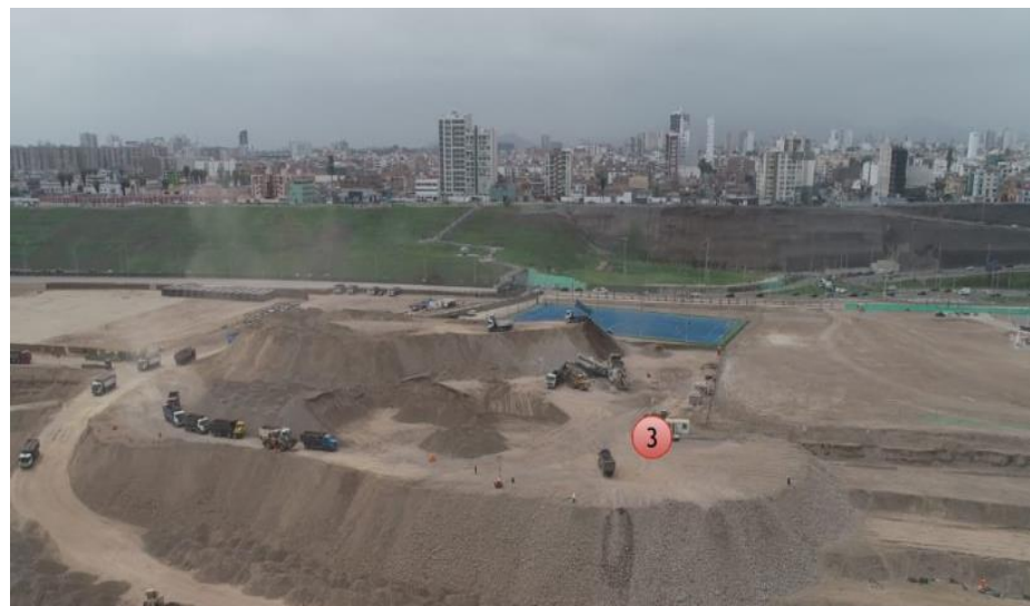
Figura N 60: Segundo punto de inspección visual.
