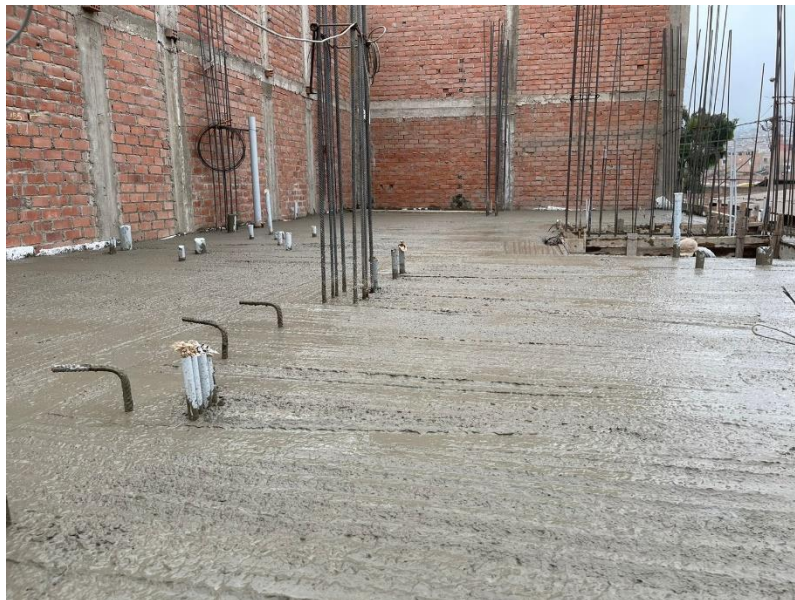
Figura N 43: Vaciado de Losa del primer nivel. Fuente: Obra Vivienda Unifamiliar Villa el Salvador-diciembre 2022
