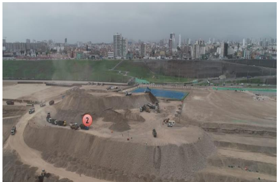
Figura N 58: Segundo punto de inspección visual.
