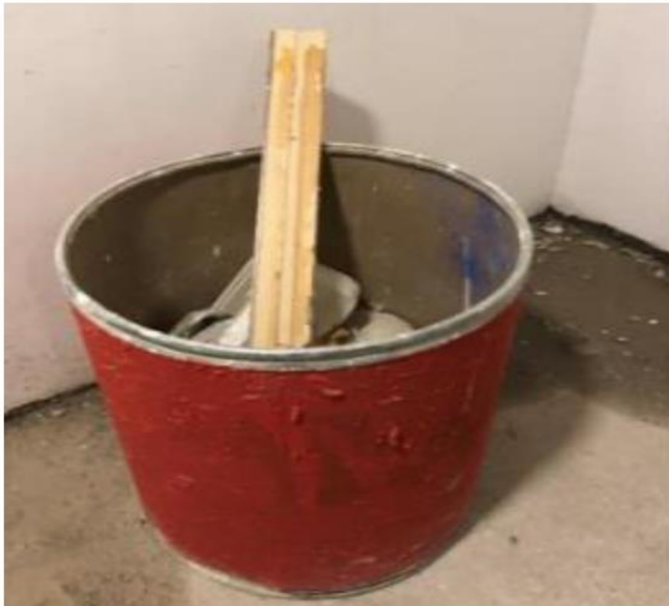
Figura N 11: Cilindros reutilizados como contenedores de residuos Fuente: Leal (2020, p.54) Proponer guía de buenas prácticas orientadas a minimizar residuos sólidos llevados a botadero en edificación en altura (Chile). Tomado de: https://repositorio.uchile.cl/bitstream/handle/2250/176851/Proponer-gu%C3%ADa-de-buenas-pr%C3%A1cticas-orientadas-a-minimizar-residuos-s%C3%B3lidos-llevados-a-botadero-en-edificaci%C3%B3n-en-altura.pdf?sequence=1&isAllowed=y
