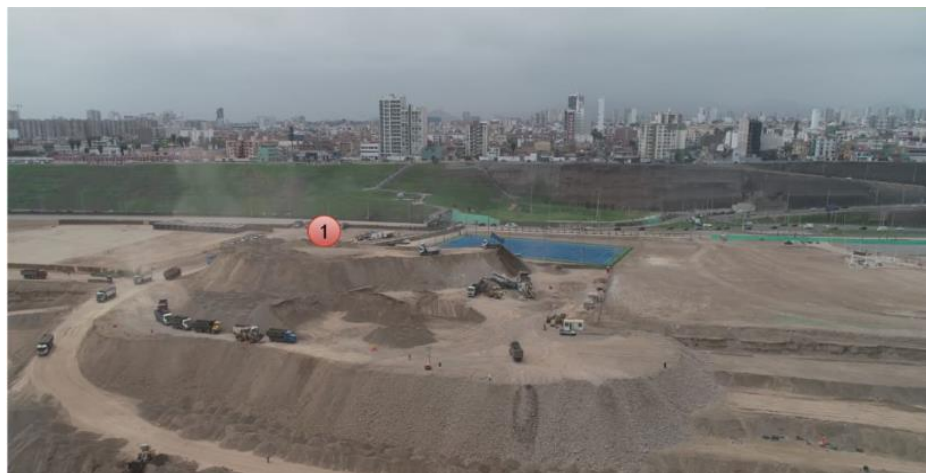
Figura N 56: Primer punto de ingreso de los camiones e inspección visual.
