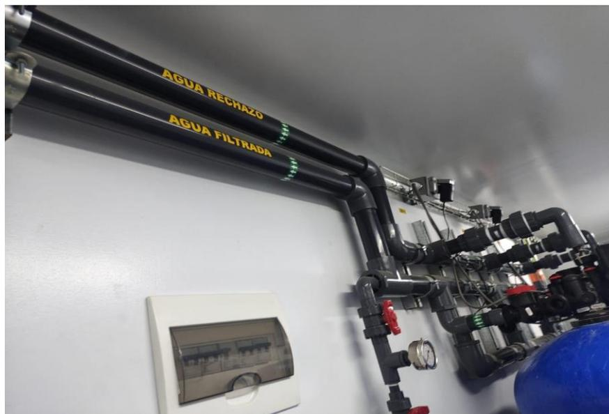
Figura 22. Tuberías de luego del tratamiento de aguas de la Ptap Mala
