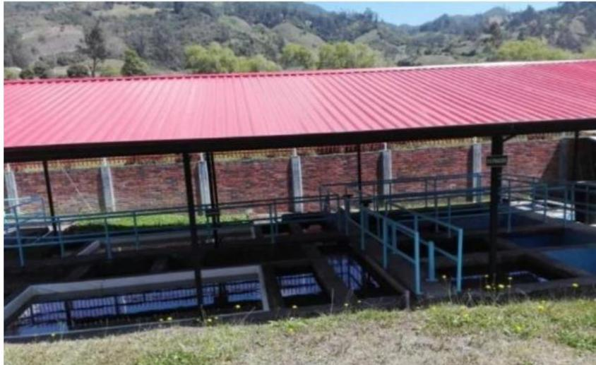
Figura 8. Planta de tratamiento de agua potable convencional.
