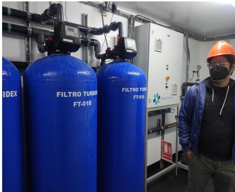
Figura 20. Tanques filtros de zeolita de la planta de tratamiento de aguas de Mala
