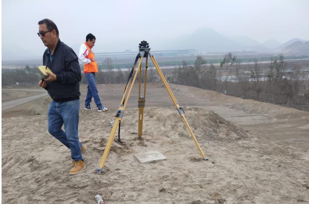
Figura 19: Armado del sistema RTK. Fuente: Elaboración propia.
