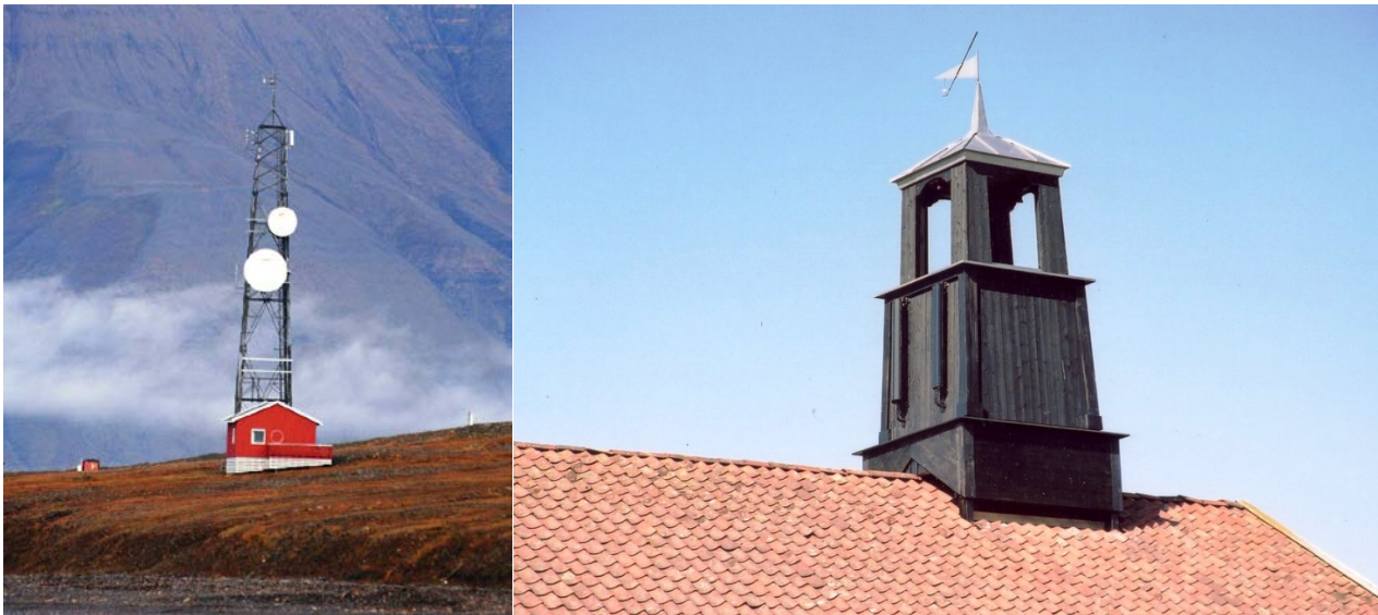
Figur 10: Eksempler på hvordan en basestasjon kan se ut. Til venstre vises basestasjonen på Hotellneset, Svalbard. Til høyre ser man en mobil basestasjon godt kamouflert ved Larvik golfbane. Kilde: Wikipedia.
