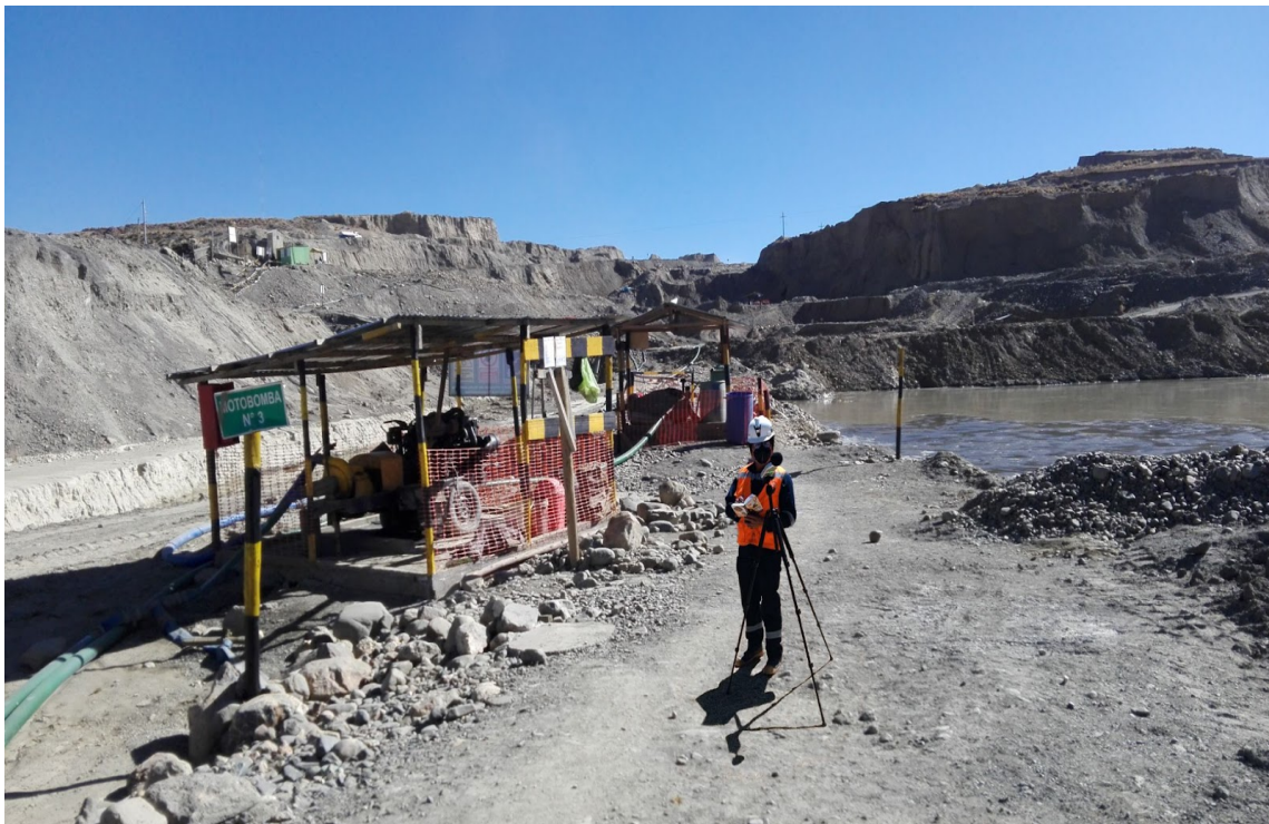
MONITOREO EN MOTOBOMBA
