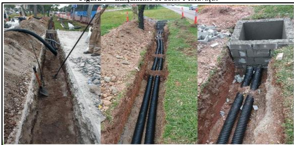
Figura 7 – Lançamento de dutos e escavação
