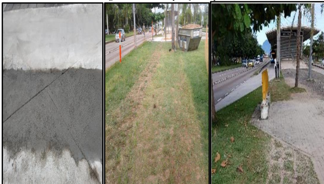
Figura 10 – Recomposição de piso
