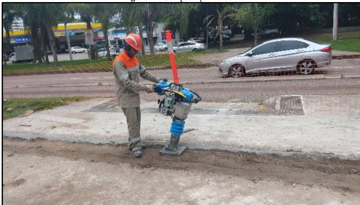
Figura 9 – Compactação do Solo
