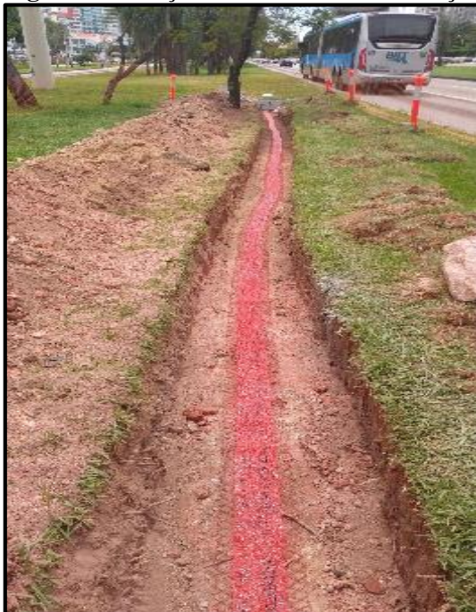
Figura 8 – Lançamento de fita de sinalização
