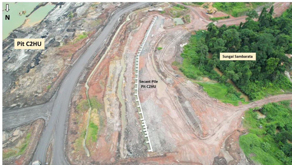
Gambar 8. Dokumentasi lapangan Dinding Penahan Tanah Secant pile Pit C2HU (Sumber: dokumentasi lapangan)
