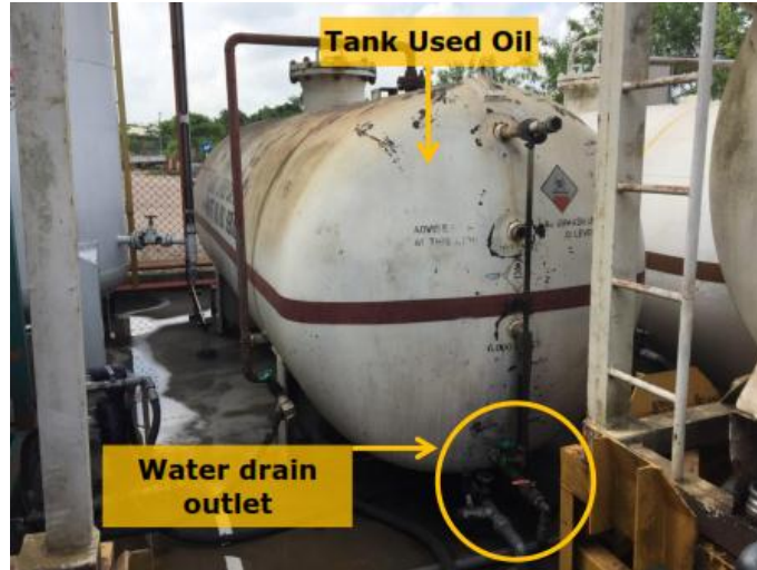
Gambar 6. Sistem pengurasan air pada tangki used oil di workshop .
